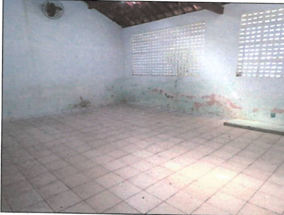
Figura 4: Instalações de sala de aula.
