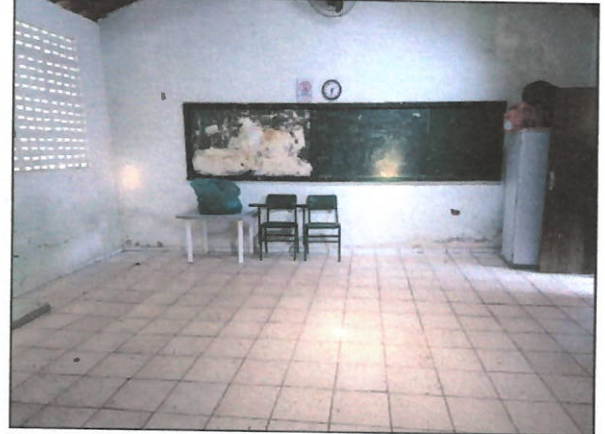
Figura 5: Instalações de sala de aula.
