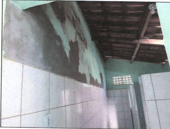
Figura 6: Instalações de banheiros.
