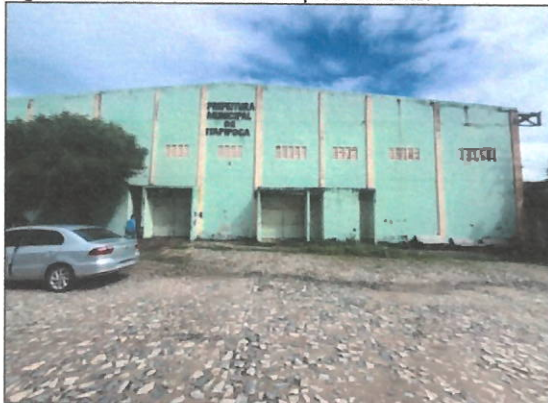
Figura 1: Entorno do local do empreendimento.
