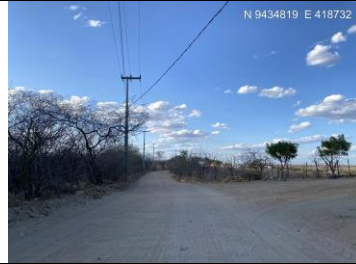
TRECHO OLHO D'ÁGUA DOS FACUNDOS A SEDE
