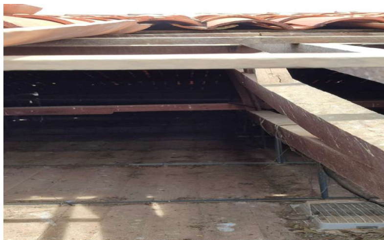
FOTO 02 – TESOURA DANIFICADA
