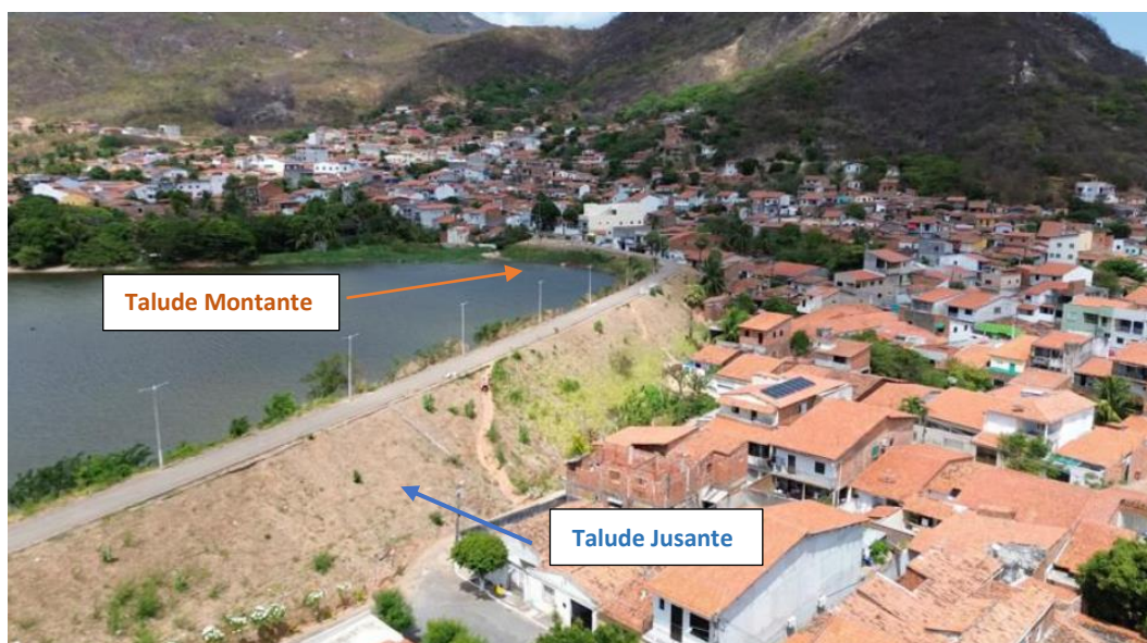
Figura 15 – Vista da Barragem da nação
