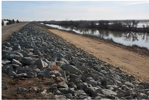
Figura 16 – Exemplo de enrocamento com pedra jogada
