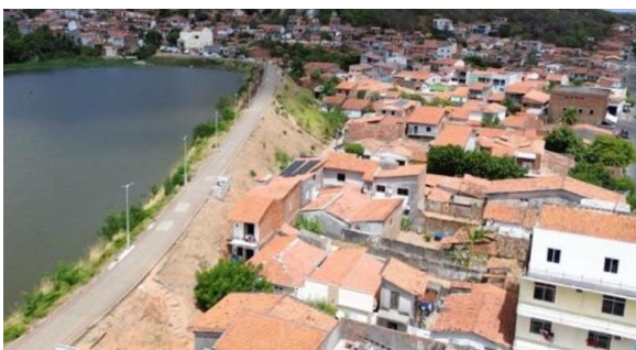
Figura 7 – Talude sem proteção vegetal.
