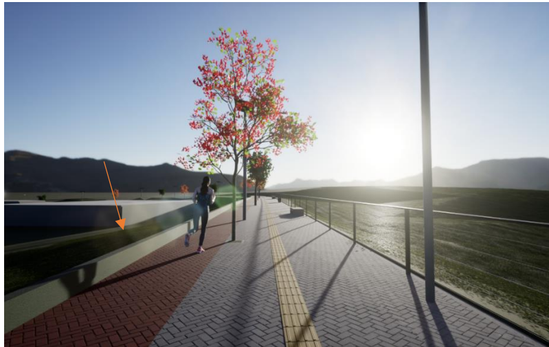
Figura 28 – Mureta em alvenaria com textura acrílica.
