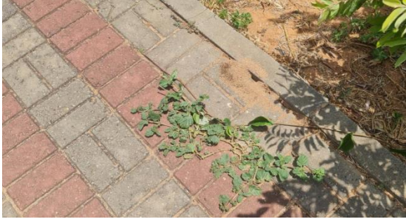
Figura 11 – Descida de água obstruída.
