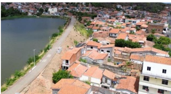
Figura 7 – Talude sem proteção vegetal.
