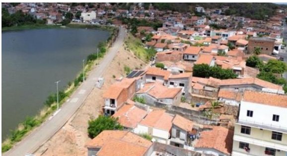
Figura 7 – Talude sem proteção vegetal.
