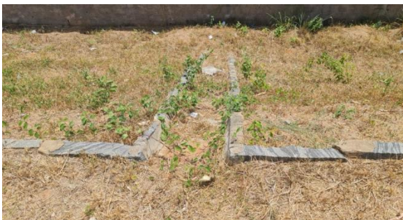
Figura 11 – Descida de água obstruída.
