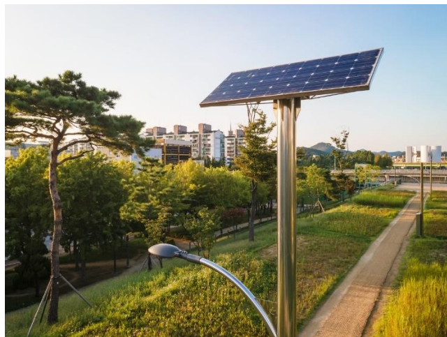
Figura 17 – Exemplo de postes com luminárias solares
