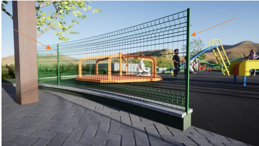
Figura 29 – Gradil Nylofor fixado na mureta em alvenaria.
