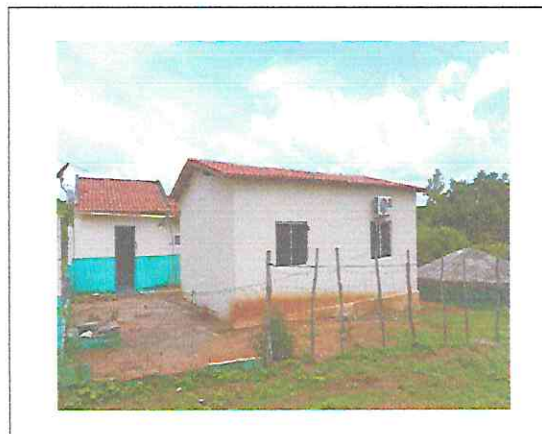
FOTO 02- FACHADA EXTERNA PRINCIPAL
