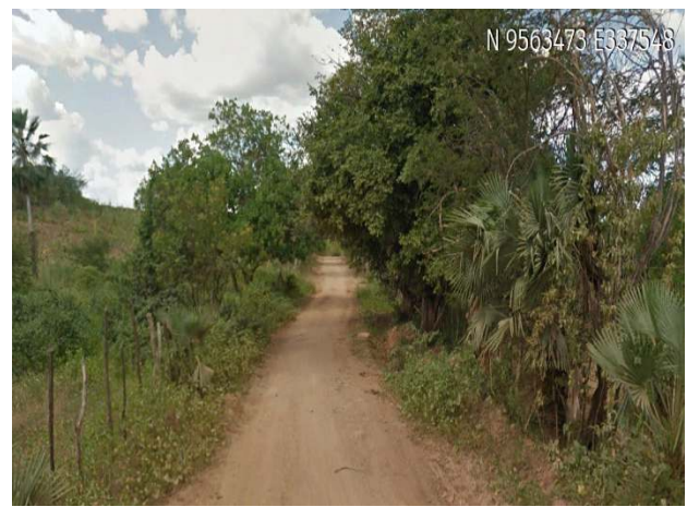
Visão geral da estrada
