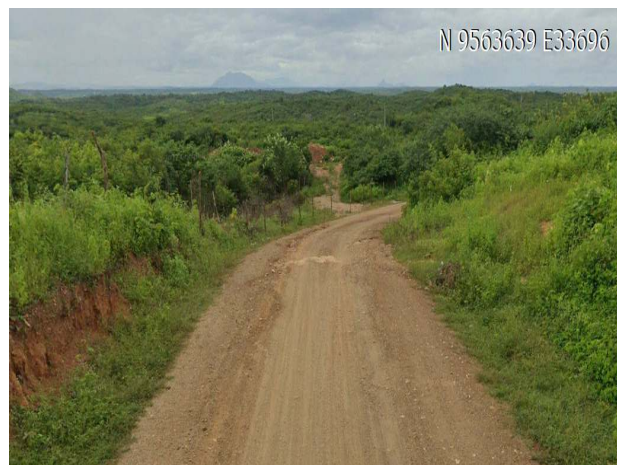
Visão geral da estrada
