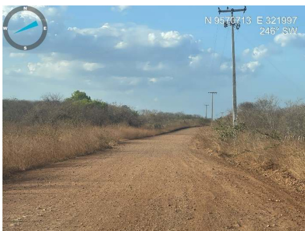
Visão geral da estrada
