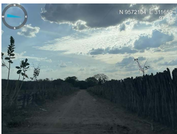
Visão geral da estrada
