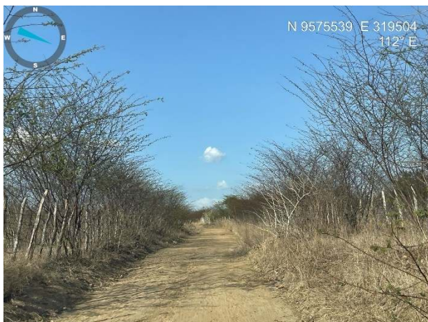
Visão geral da estrada
