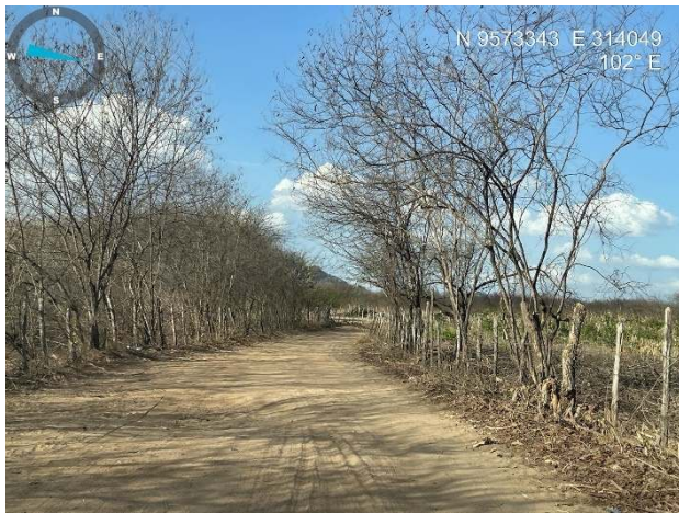
Visão geral da estrada
