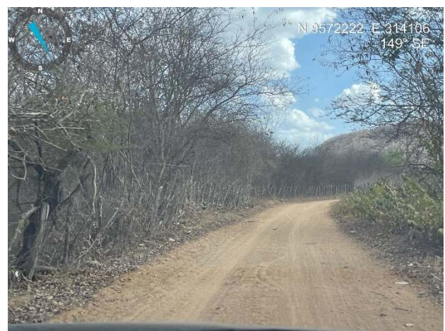
Visão geral da estrada
