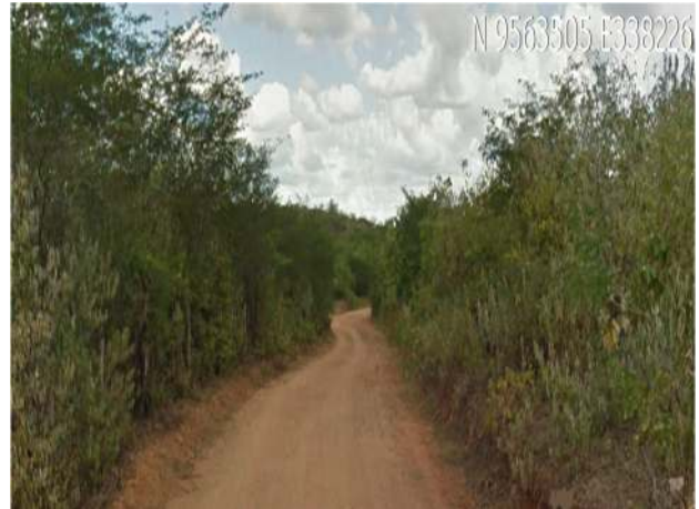
Visão geral da estrada e Bueiro existente
