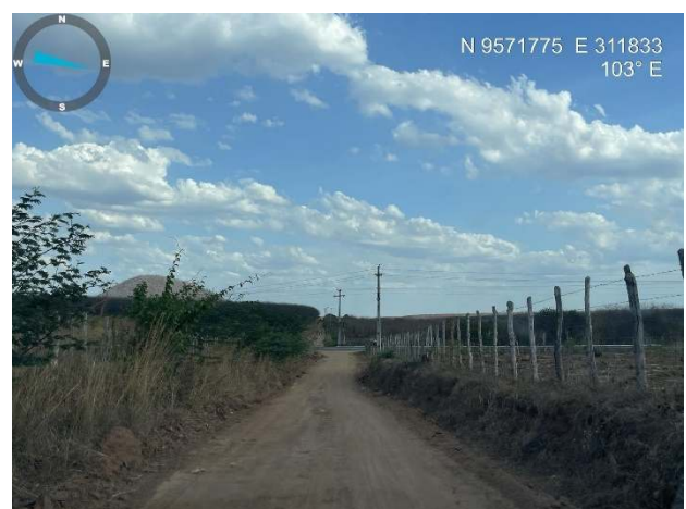
Visão geral da estrada
