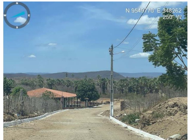
Visão geral da estrada
