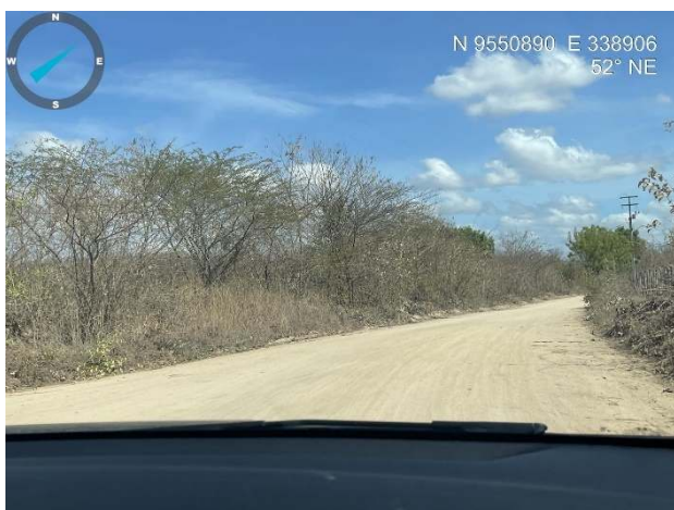
Visão geral da estrada
