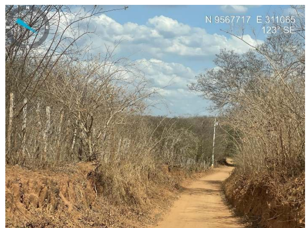
Visão geral da estrada
