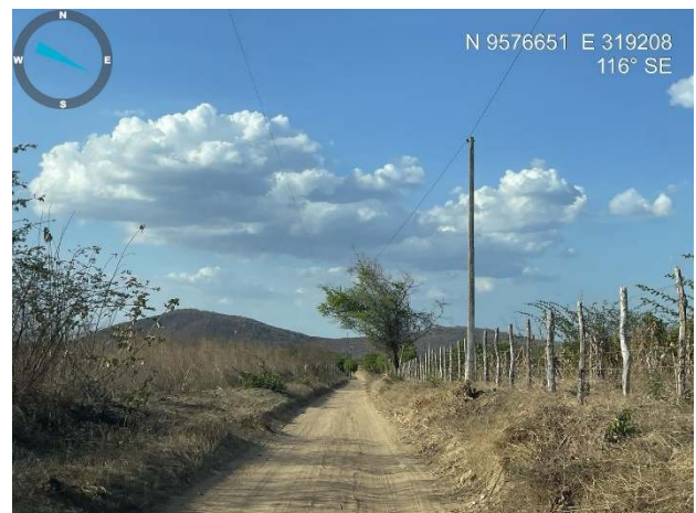
Visão geral da estrada
