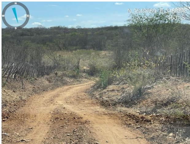
Visão geral da estrada
