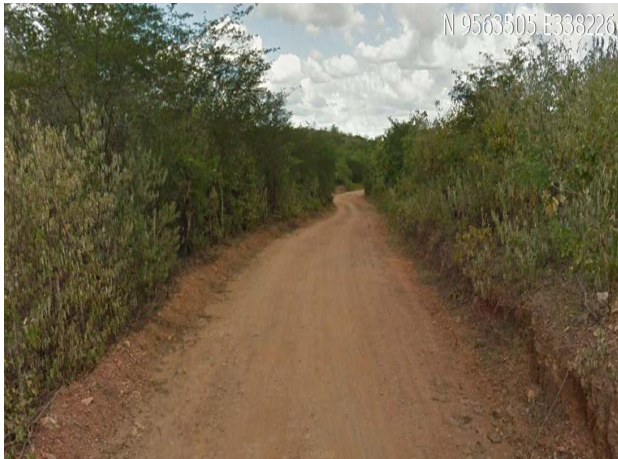
Visão geral da estrada
