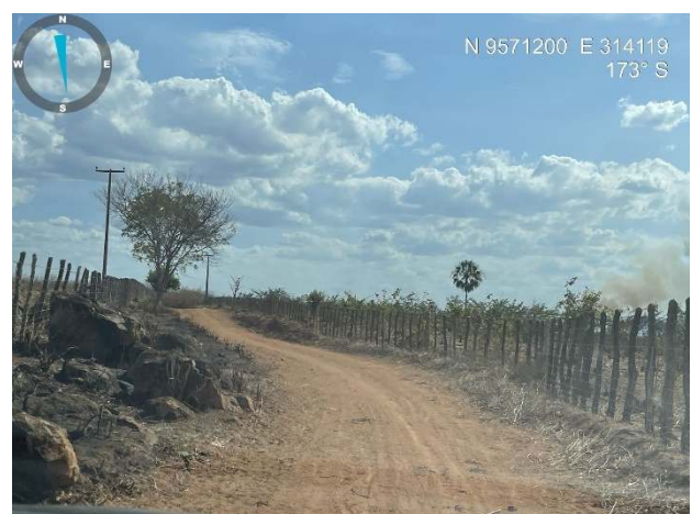
Visão geral da estrada
