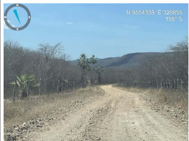
Visão geral da estrada
