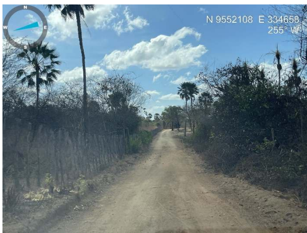
Visão geral da estrada
