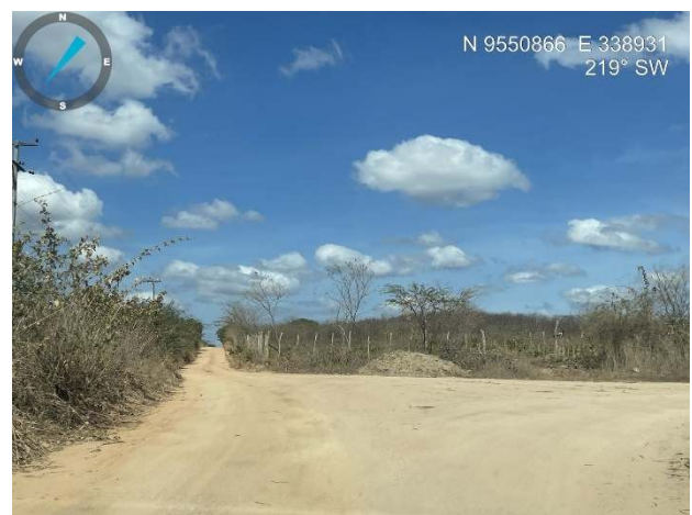
Visão geral da estrada
