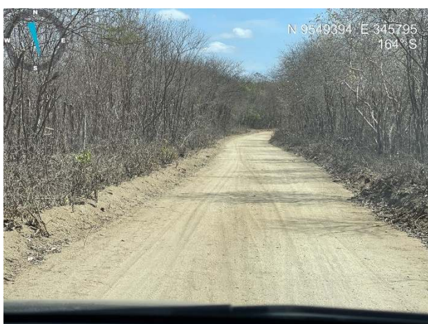
Visão geral da estrada
