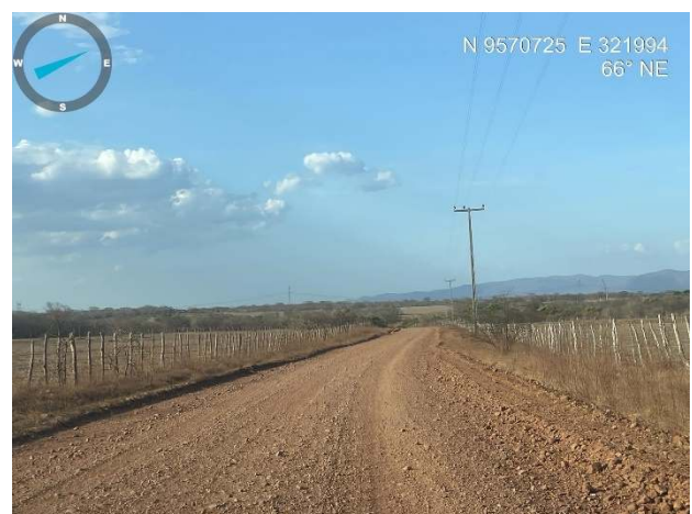
Visão geral da estrada
