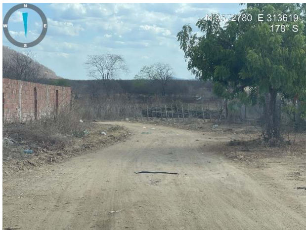
Visão geral da estrada
