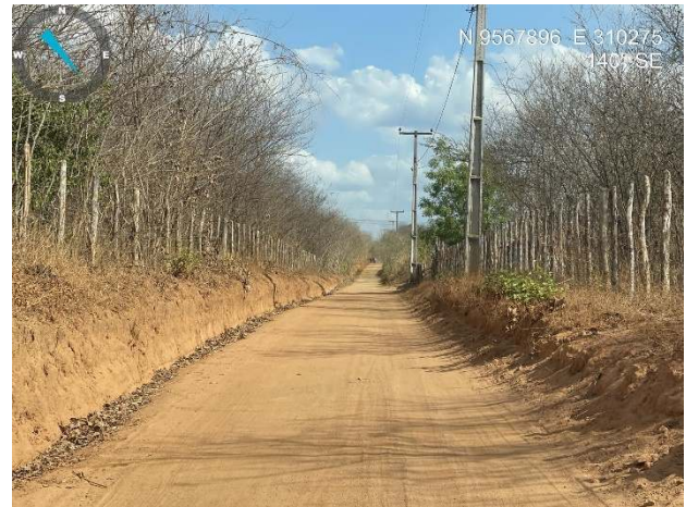
Visão geral da estrada
