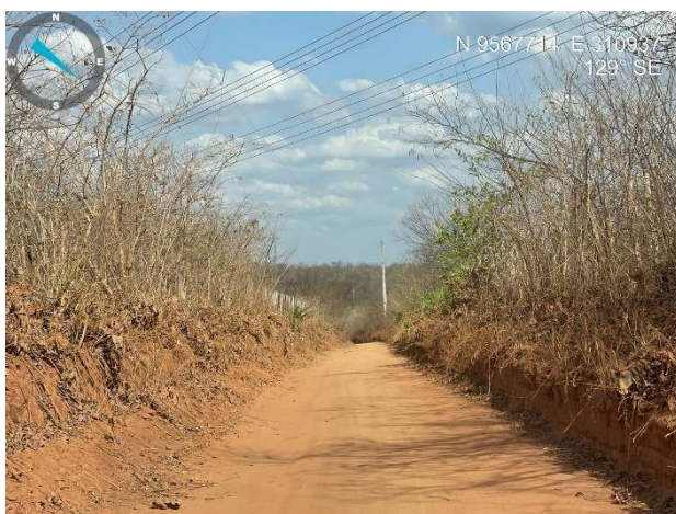
Visão geral da estrada
