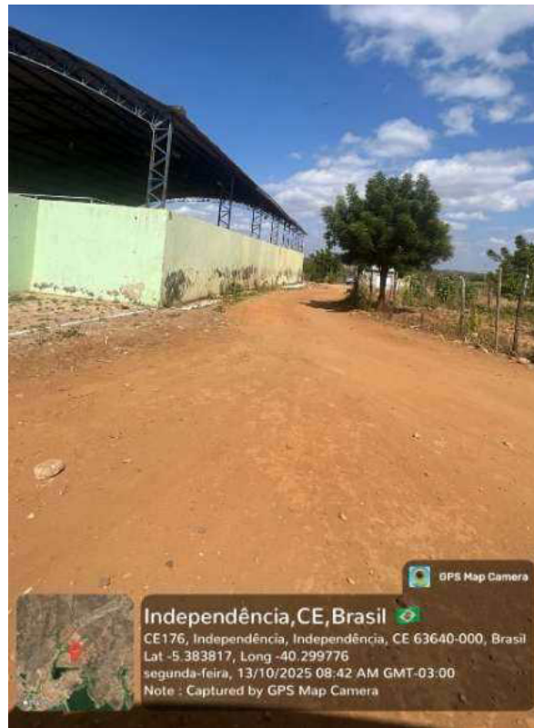
Figura 16 - RUA S/D OFICIAL - 05 – INÍCIO
