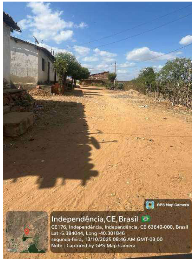
Figura 24 - RUA SDO (TERRENO NATURAL) - INÍCIO
