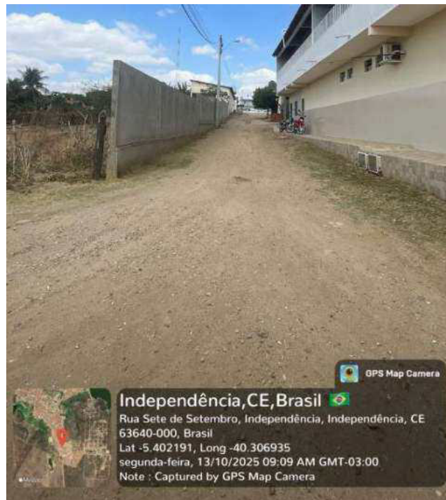
Figura 47 - RUA RUI BARBOSA - INÍCIO
