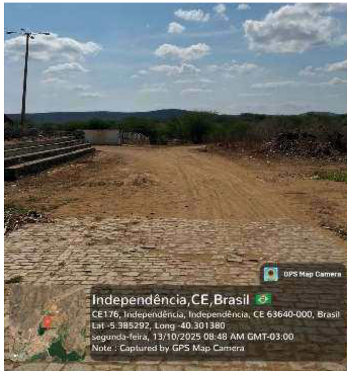
Figura 26 - RUA CONJUNTO SANTA RITA (TERRENO NATURAL)
