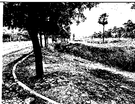
Visão do Local da Construção (2)
