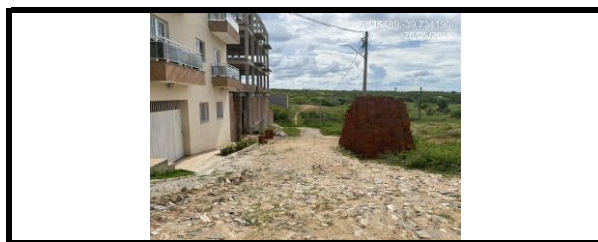
RUA PROJETADA SDO - PONTE NOVA
