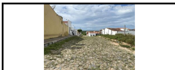
RUA ELIEL RAFAEL DA SILVA - PONTE NOVA
