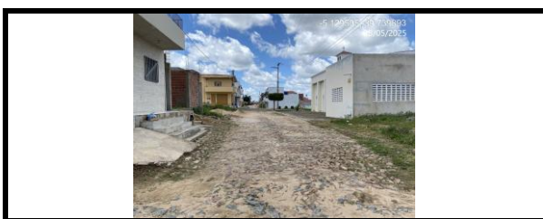
RUA LUIS FERNANDES CARNEIRO - PONTE NOVA
