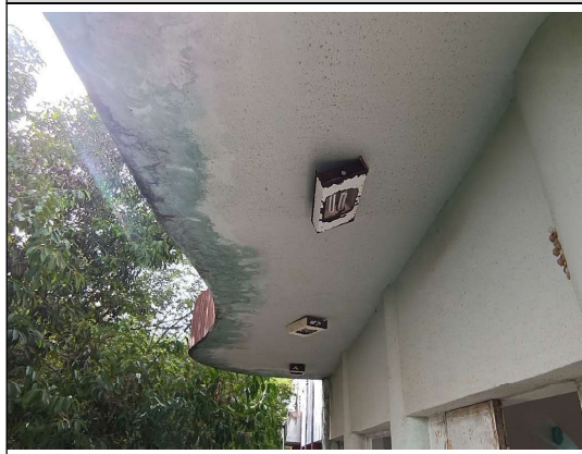
Foto 58 - Sacada a ser demolida.
