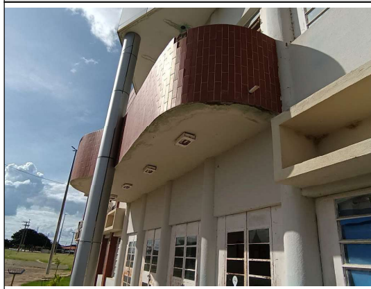
Foto 14 - Vista exterior prédio.
