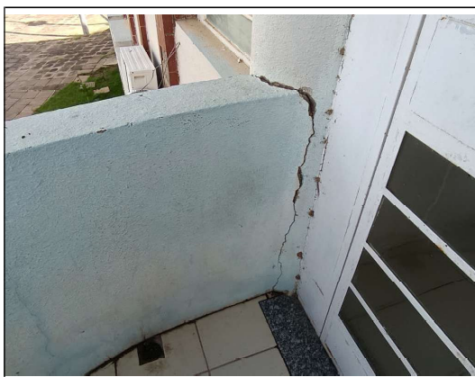
Foto 41 - Sacada a ser demolida.
