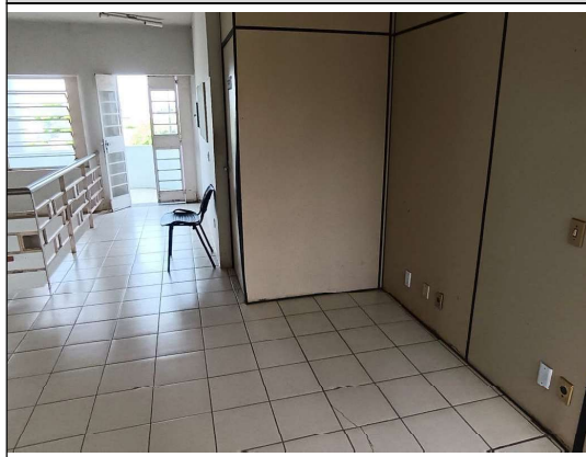
Foto 32 - Divisórias das salas.
