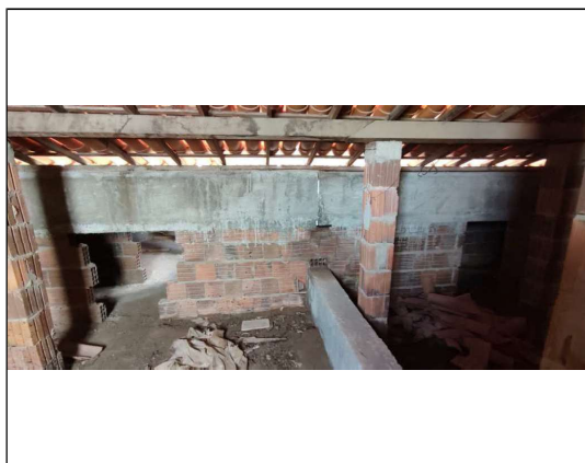
Foto 67 - Estrutura da coberta existente.
