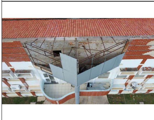
Foto 08 - Vista exterior prédio.
