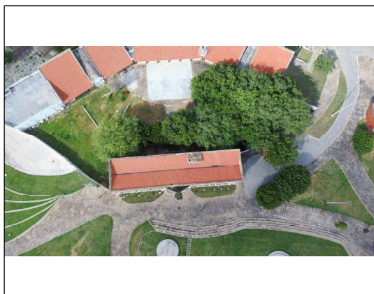
Foto 10 - Vista exterior prédio.
