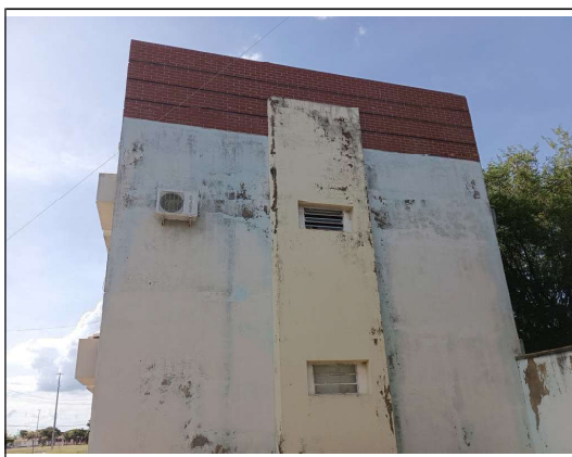
Foto 11 - Vista exterior prédio.
