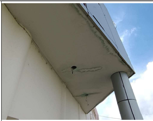
Foto 39 - Sacada a ser demolida.
