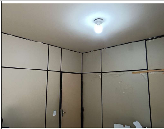
Foto 52 - Divisórias das salas.
