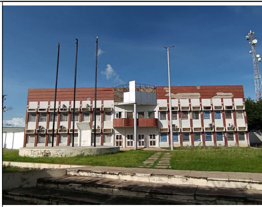
Foto 15 - Vista exterior prédio.
