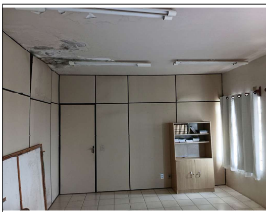
Foto 17 - Divisórias das salas.
