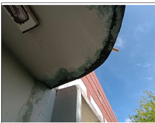
Foto 57 - Sacada a ser demolida.
