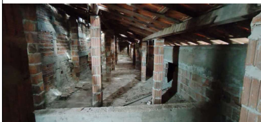
Foto 72 - Estrutura da cobertura existente.
