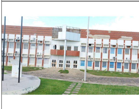
Foto 01 - Vista exterior prédio.
