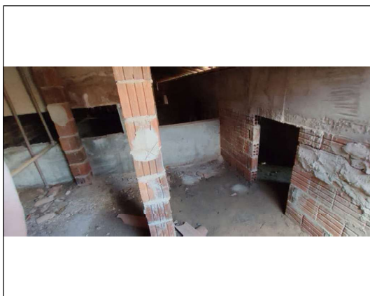
Foto 68 - Estrutura da coberta existente.
