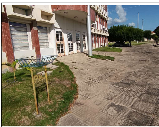
Foto 13 - Vista exterior prédio.
