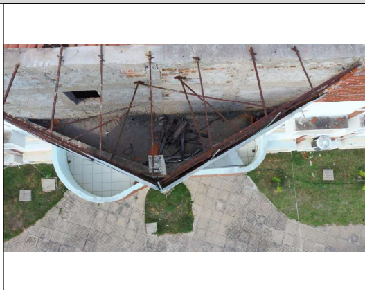
Foto 09 - Vista exterior prédio.
