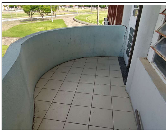
Foto 40 - Sacada a ser demolida.
