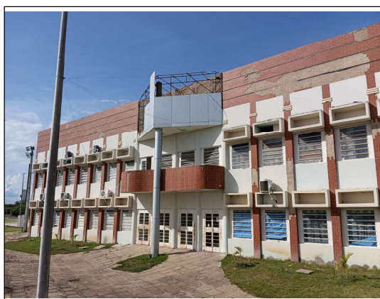
Foto 12 - Vista exterior prédio.
