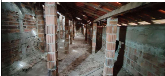
Foto 71 - Estrutura da cobertura existente.
