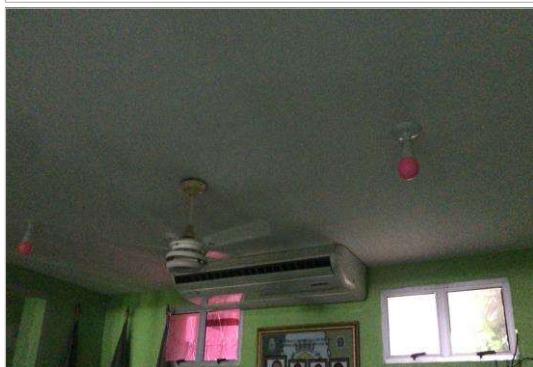
REFORMA DA CÂMARA MUNICIPAL DE BOA VIAGEM.
