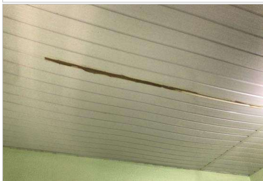
REFORMA DA CÂMARA MUNICIPAL DE BOA VIGAEM.
