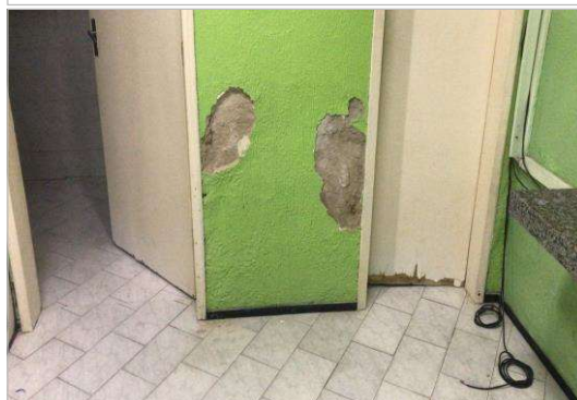
REFORMA DA CÂMARA MUNICIPAL DE BOA VIGAEM.
