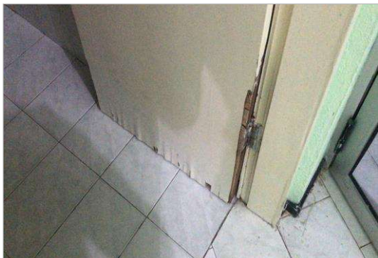
REFORMA DA CÂMARA MUNICIPAL DE BOA VIGAEM.
