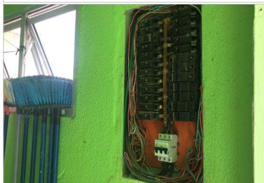
REFORMA DA CÂMARA MUNICIPAL DE BOA VIGAEM.
