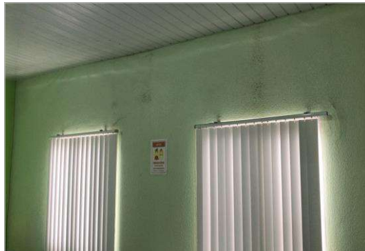
REFORMA DA CÂMARA MUNICIPAL DE BOA VIAGEM.
