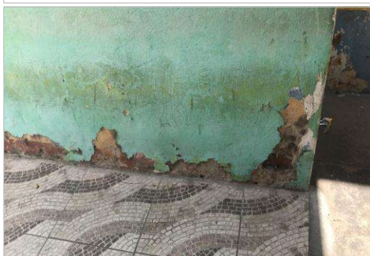
REFORMA DA CÂMARA MUNICIPAL DE BOA VIGAEM.
