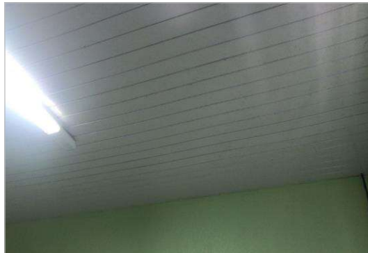
REFORMA DA CÂMARA MUNICIPAL DE BOA VIGAEM.
