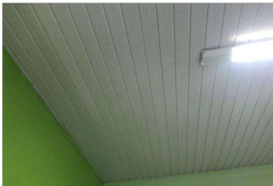
REFORMA DA CÂMARA MUNICIPAL DE BOA VIGAEM.
