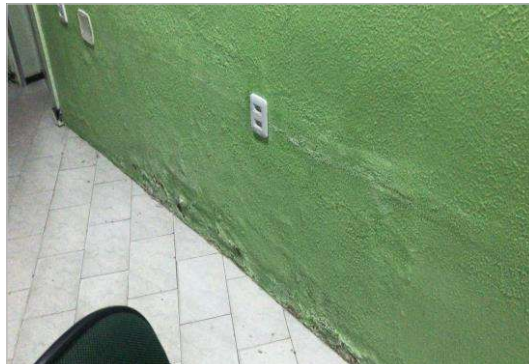
REFORMA DA CÂMARA MUNICIPAL DE BOA VIGAEM.
