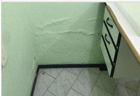
REFORMA DA CÂMARA MUNICIPAL DE BOA VIAGEM.
