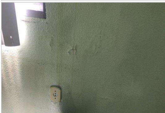
REFORMA DA CÂMARA MUNICIPAL DE BOA VIGAEM.
