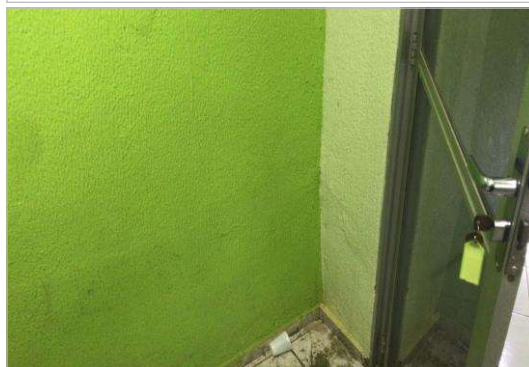
REFORMA DA CÂMARA MUNICIPAL DE BOA VIAGEM.
