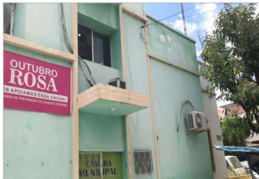
REFORMA DA CÂMARA MUNICIPAL DE BOA VIGAEM.
