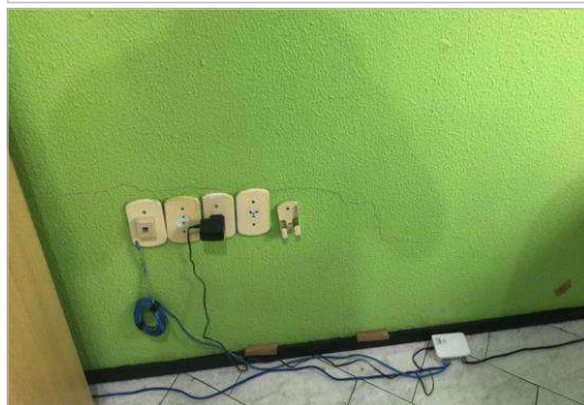
REFORMA DA CÂMARA MUNICIPAL DE BOA VIGAEM.
