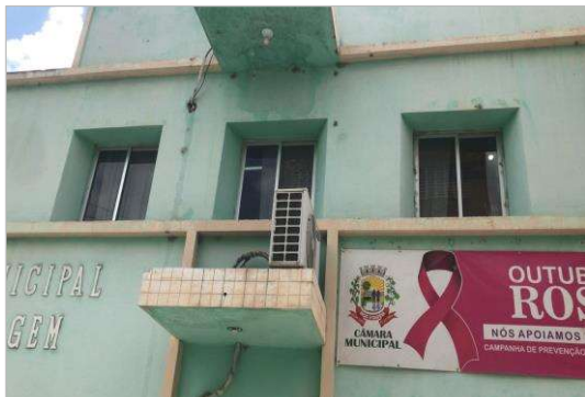
REFORMA DA CÂMARA MUNICIPAL DE BOA VIGAEM.
