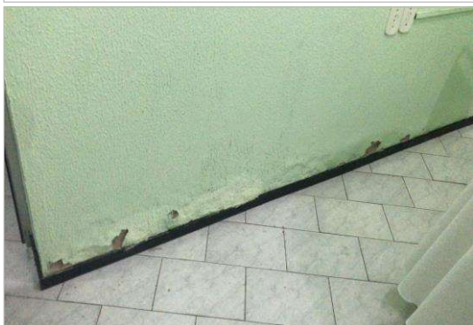
REFORMA DA CÂMARA MUNICIPAL DE BOA VIGAEM.
