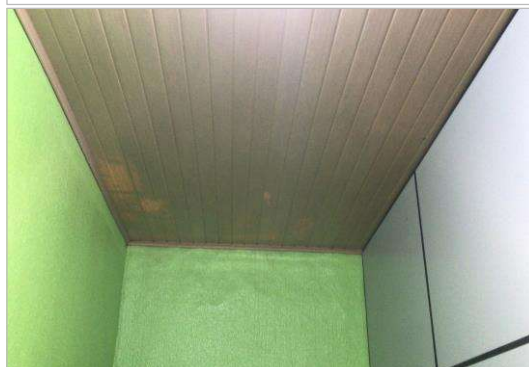
REFORMA DA CÂMARA MUNICIPAL DE BOA VIGAEM.
