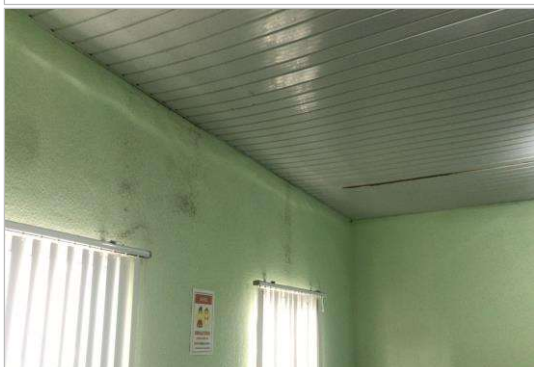
REFORMA DA CÂMARA MUNICIPAL DE BOA VIGAEM.
