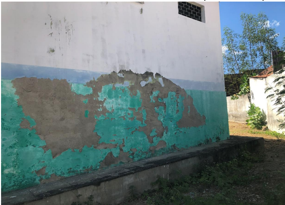
Figura 5 – PINTURA DANIFICADA
