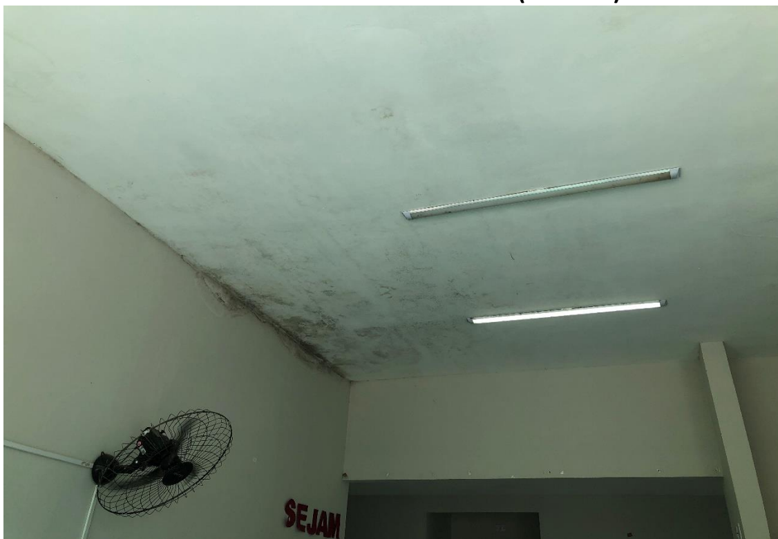
Figura 5 – PINTURA DANIFICADA
