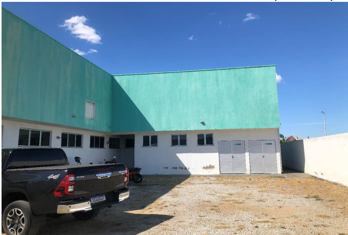
Figura 3 – FACHADA – LATERAL / FUNDOS
