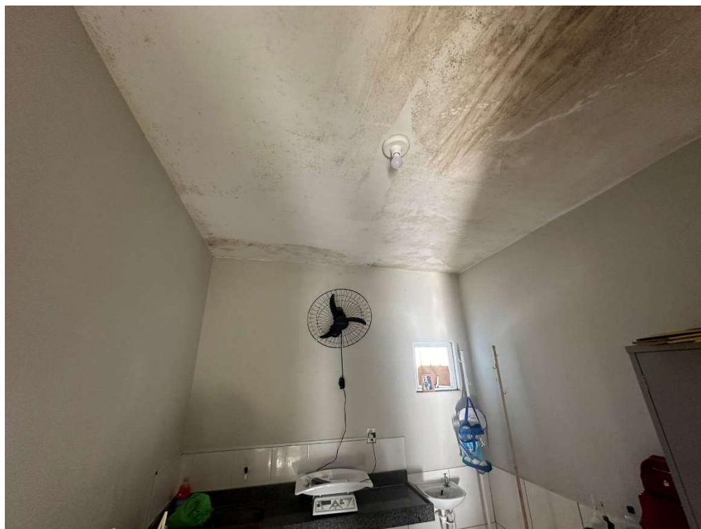
Figura 8 – INFILTRAÇÃO
