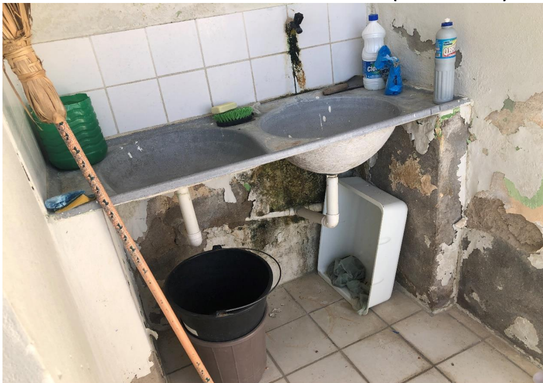
Figura 7 – REVESTIMENTO DANIFICADO
