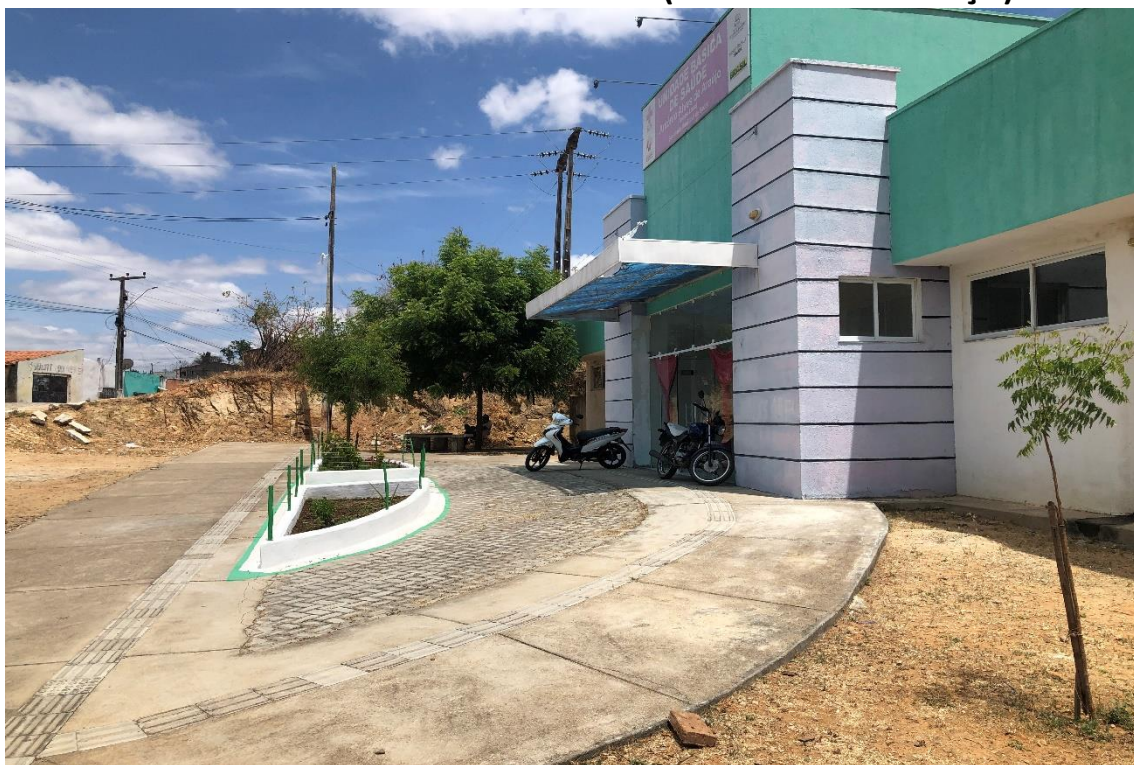
Figura 1 – FACHADA FRONTAL E CALÇADA
