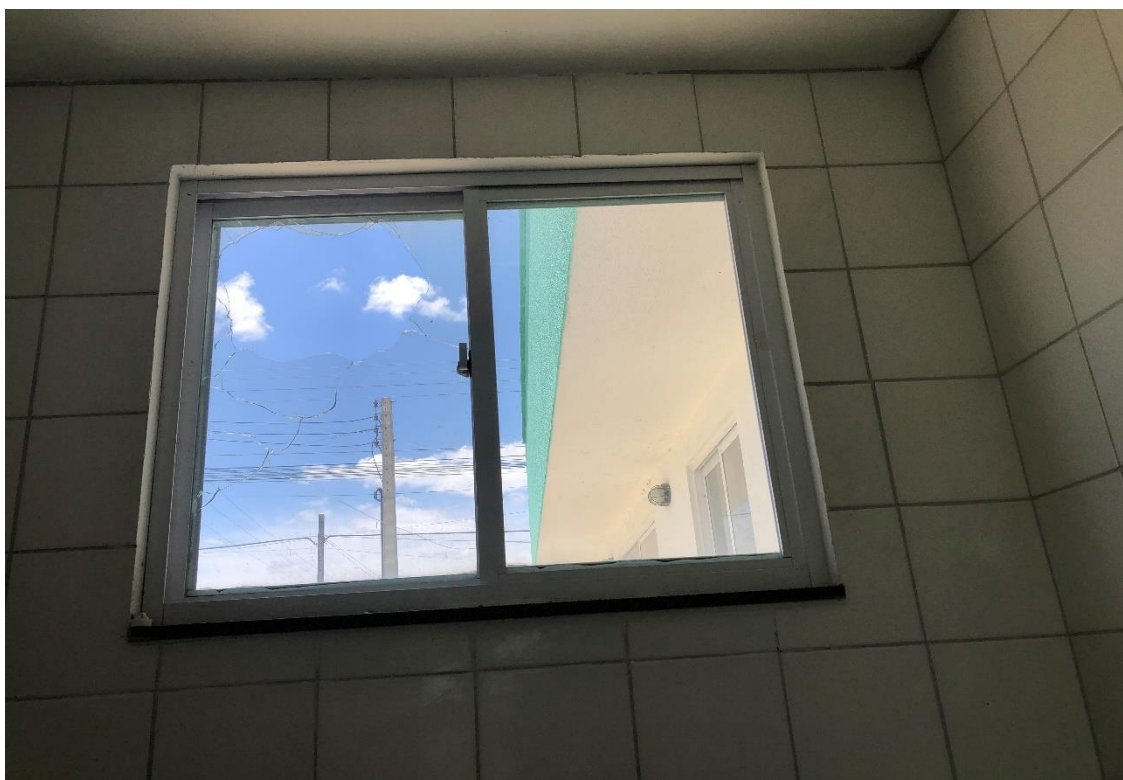
Figura 4 – JANELA QUEBRADA
