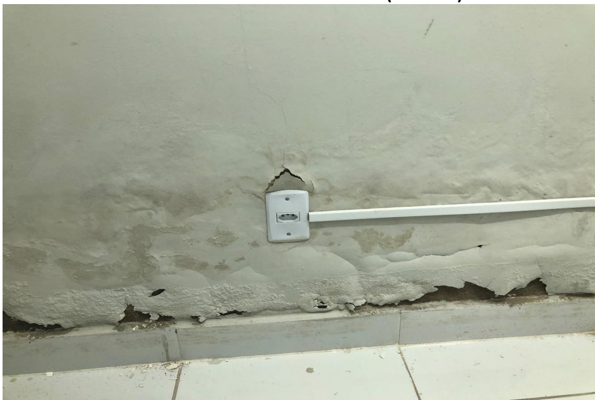
Figura 7 – REVESTIMENTO DANIFICADO
