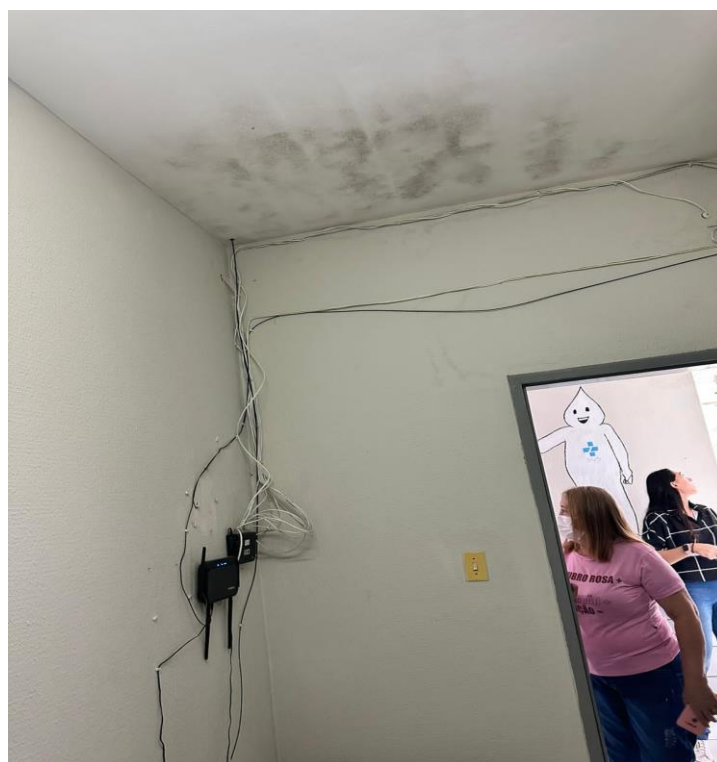
Figura 4 – PINTURA DANIFICADA
