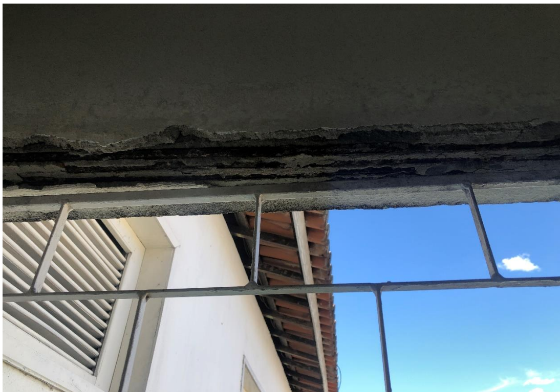
Figura 8 – FERRAGEM EXPOSTA
