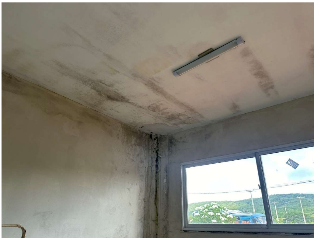
Figura 7 – INFILTRAÇÃO
