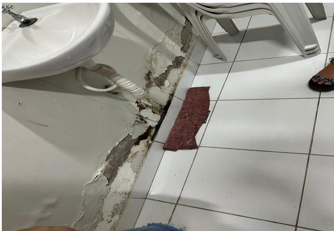
Figura 8 – REVESTIMENTO DANIFICADO
