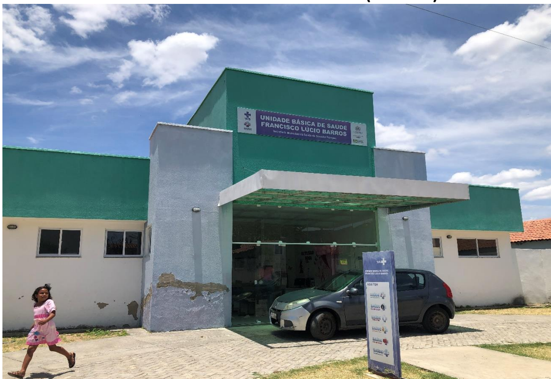
Figura 1 – FACHADA FRONTAL E CALÇADA
