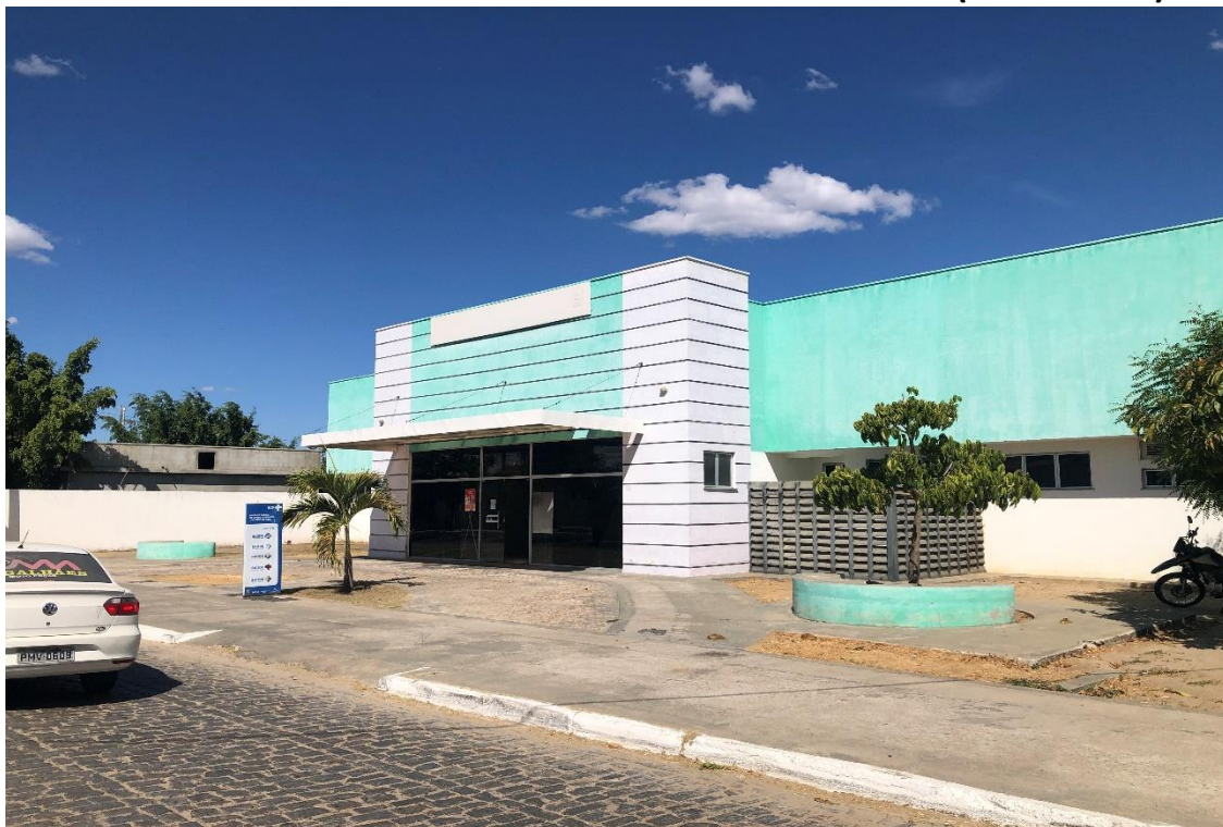
Figura 1 – FACHADA FRONTAL E CALÇADA
