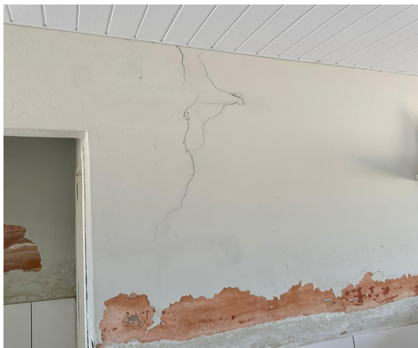
Figura 2 – REVESTIMENTO DANIFICADO
