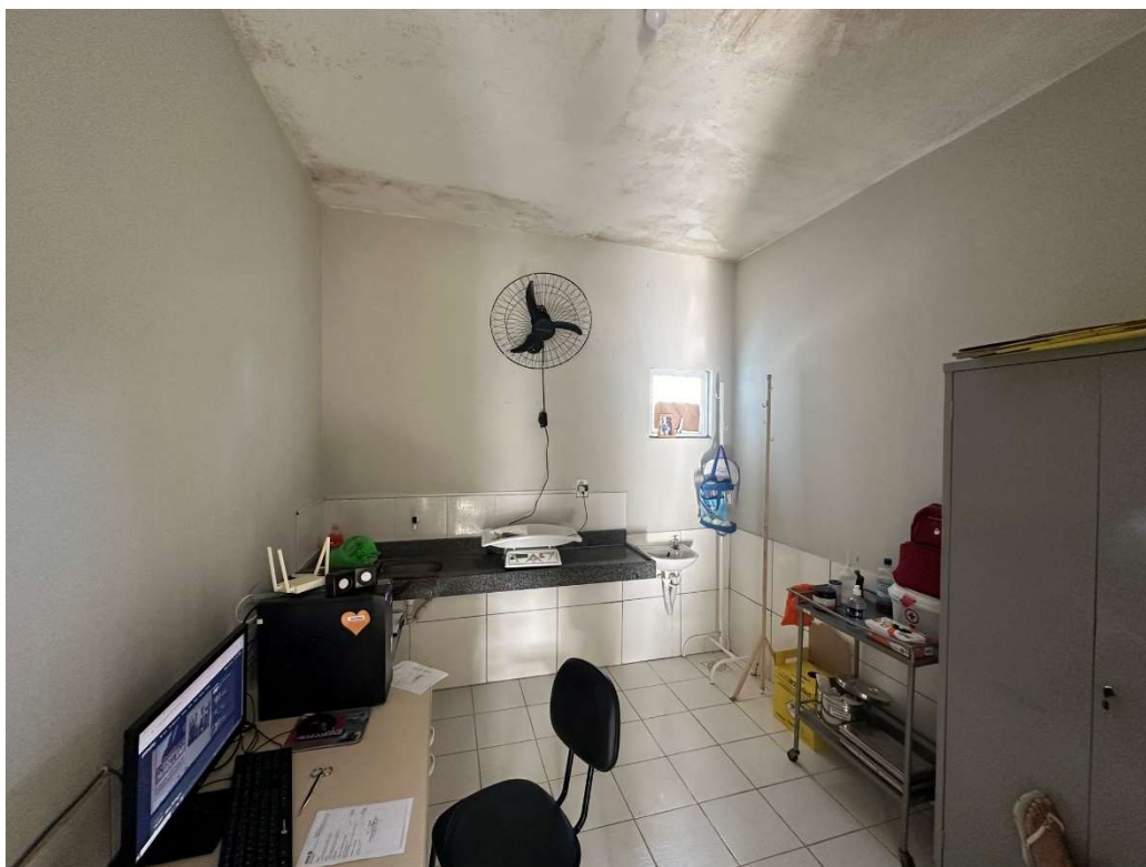
Figura 9 – INFILTRAÇÃO
