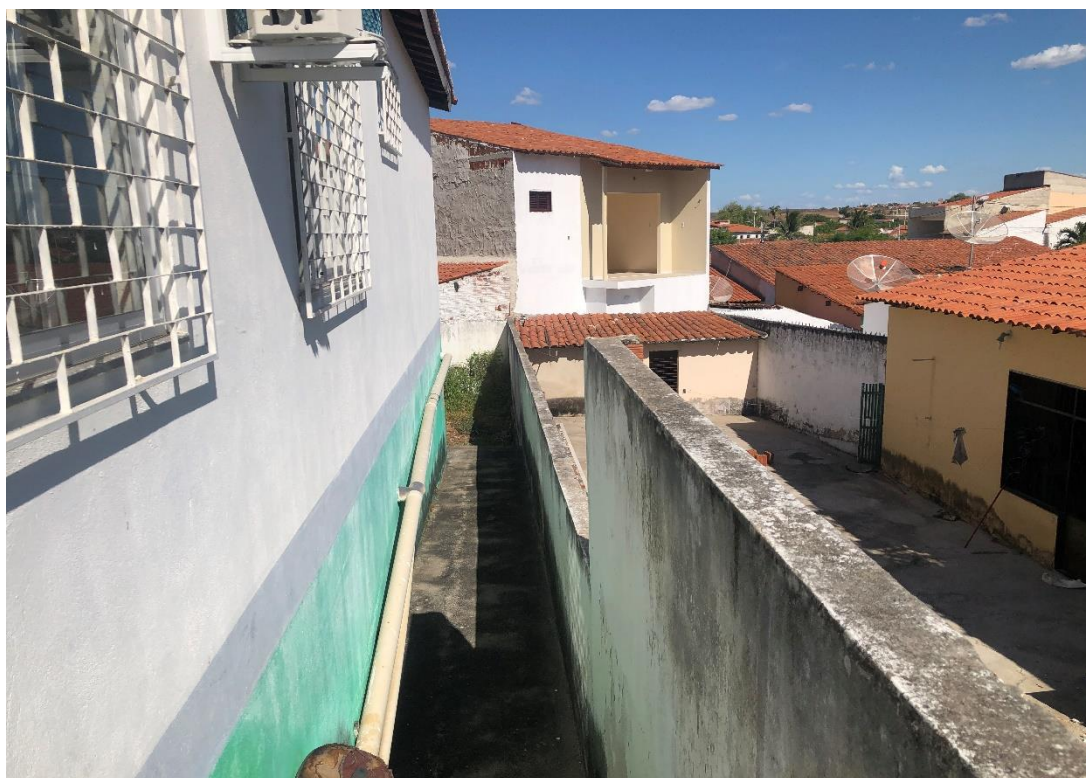
Figura 4 – FACHADA LATERAL – DIFERENÇA MURO DE PROTEÇÃO
