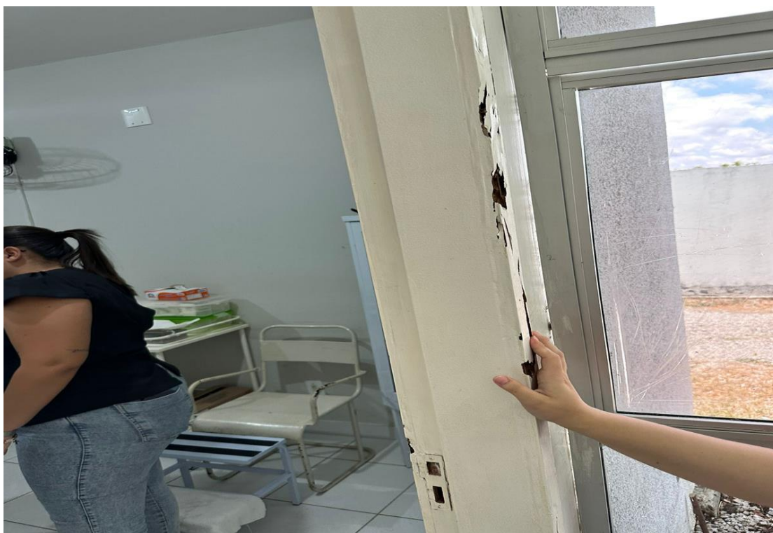
Figura 6 – FORRAMENTO DANIFICADO
