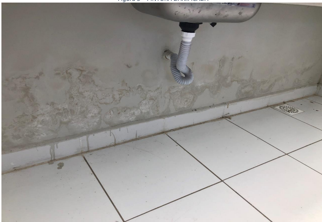
Figura 6 – REVESTIMENTO DANIFICADO
