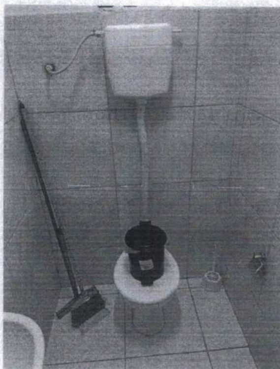
Foto 06 – Vista do banheiro da Unidade Básica de Saúde Espreado
