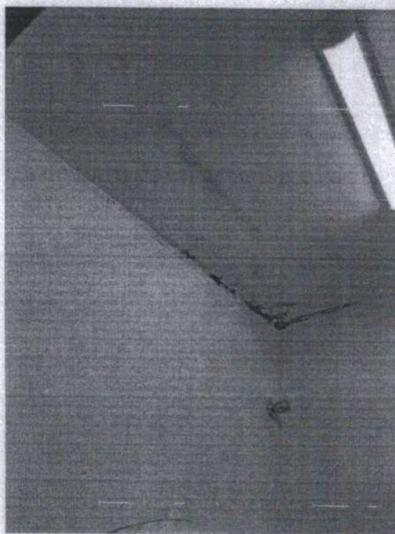
Foto 05 – Vista do forro da Unidade Básica de Saúde Espreado
