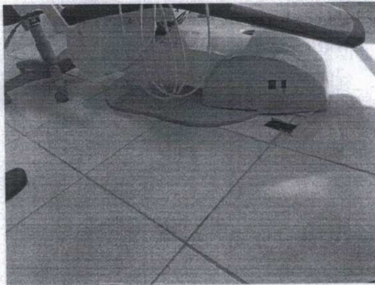
Foto 02 – Vista do Piso da Unidade Básica de Saúde Espraiado
