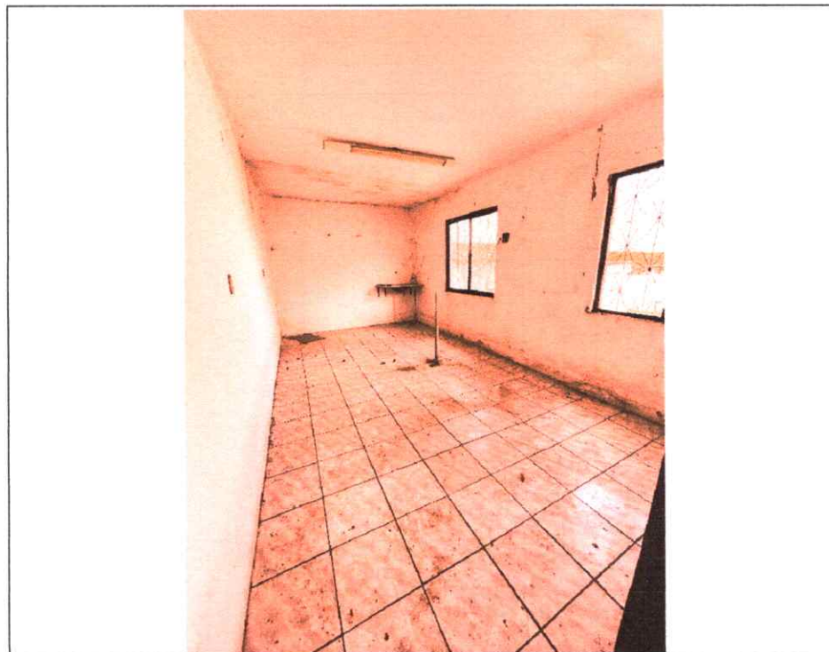
Imagem 04 - Vista da sala – será realizada troca do revestimento, recuperação das esquadrias, reboco e pintura, além de nova instalação elétrica.
