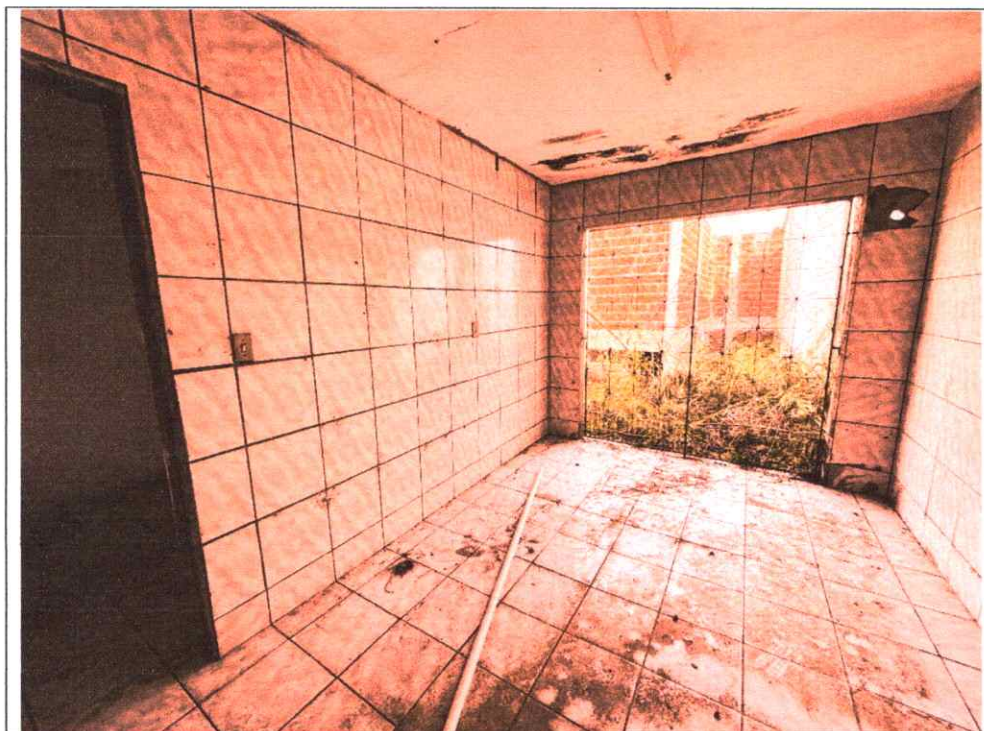
Imagem 02 - Vista do futuro espaço da cozinha – será realizada troca dos revestimentos e substituição da grade por porta e janela.
