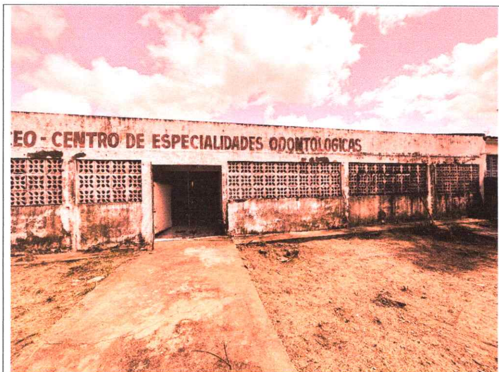
Imagem 01 - Vista da fachada frontal antes da reforma. Local será modificado para implantação de estacionamento e novo acesso.
