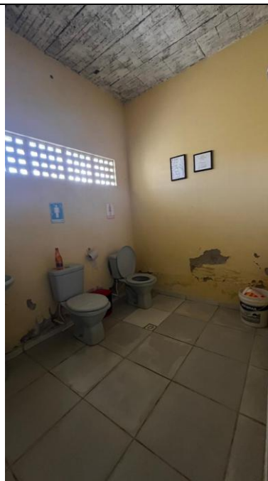
Foto 03: Divisão de banheiro em masculino e feminino.
