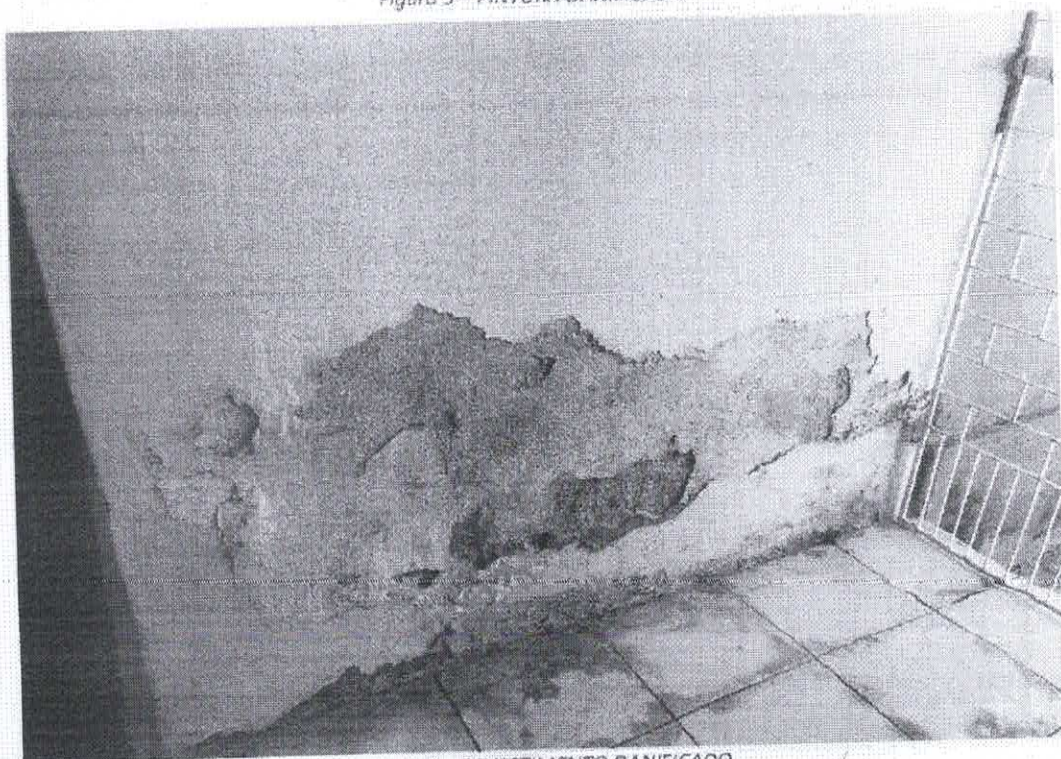
Figura 6 – REVESTIMENTO DANIFICADO
