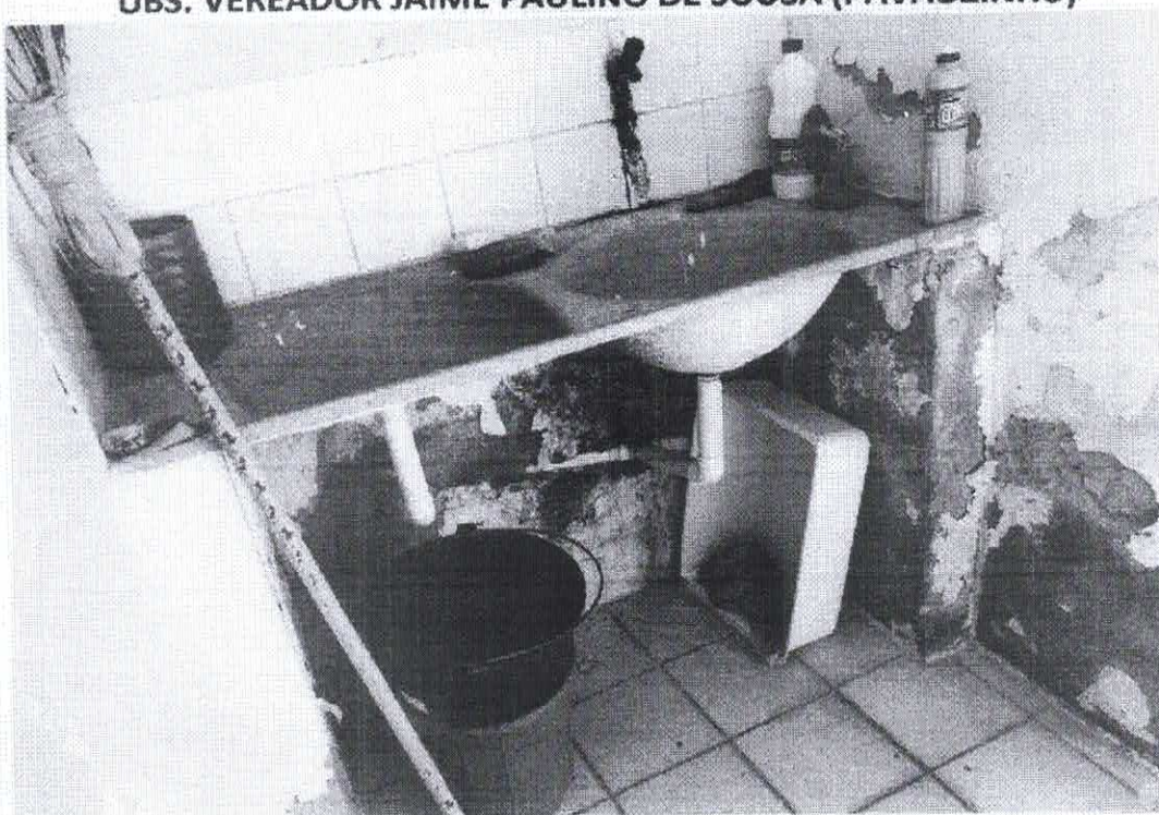
Figura 7 – REVESTIMENTO DANIFICADO
