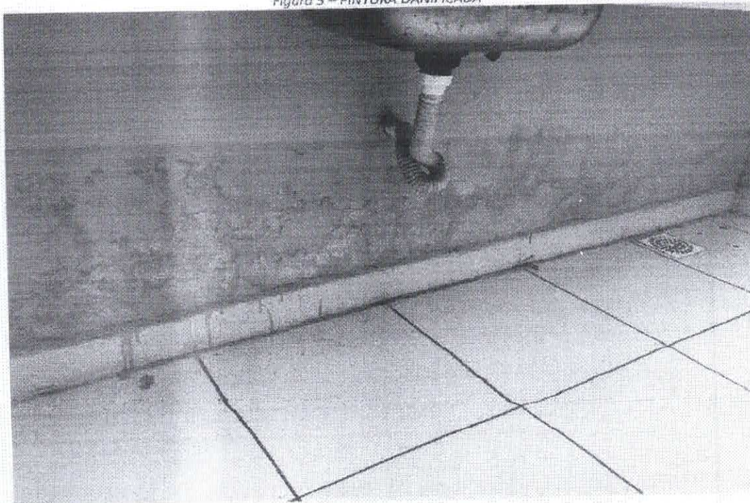
Figura 6 – REVESTIMENTO DANIFICADO
