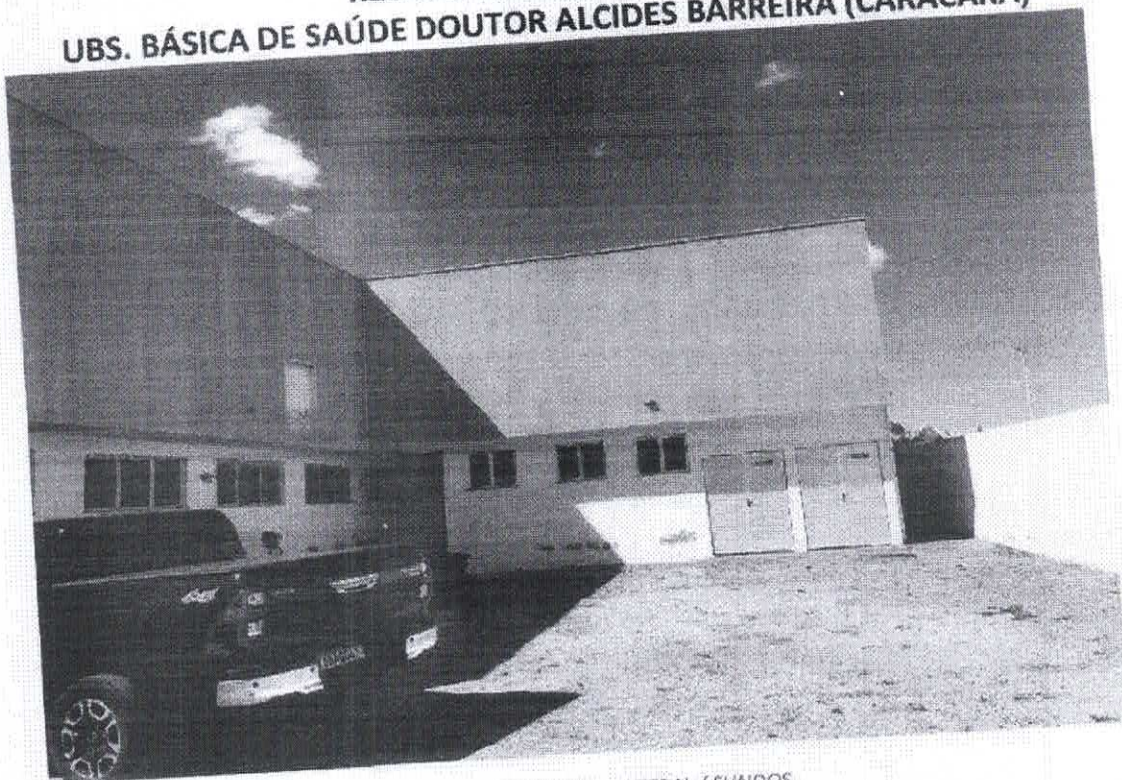
Figura 3 – FACHADA – LATERAL / FUNDOS
