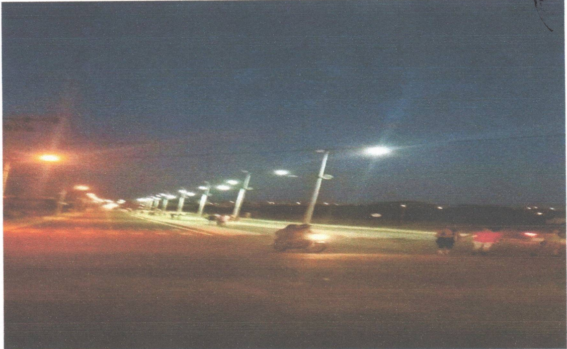
AVENIDA SÃO FRANCISCO
