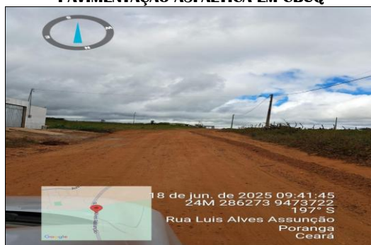
PAVIMENTAÇÃO ASFÁLTICA EM CBUQ
