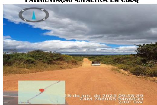
PAVIMENTAÇÃO ASFÁLTICA EM CBUQ
