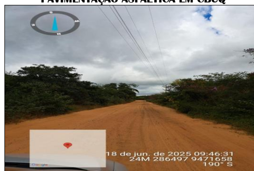
PAVIMENTAÇÃO ASFÁLTICA EM CBUQ
