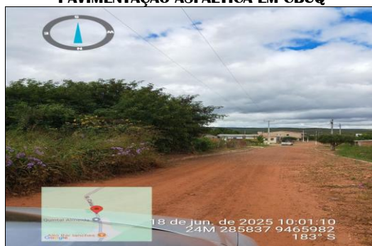
PAVIMENTAÇÃO ASFÁLTICA EM CBUQ
