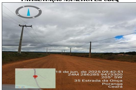
PAVIMENTAÇÃO ASFÁLTICA EM CBUQ
