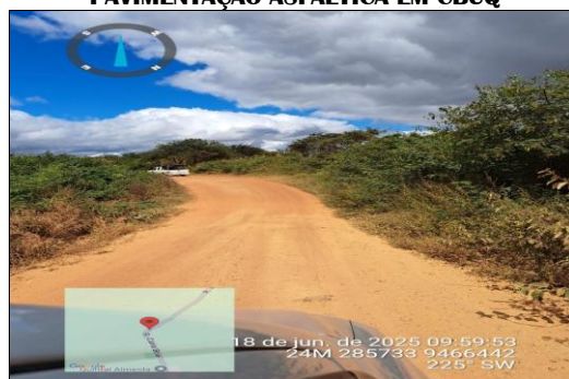
PAVIMENTAÇÃO ASFÁLTICA EM CBUQ
