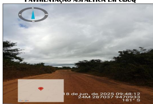
PAVIMENTAÇÃO ASFÁLTICA EM CBUQ
