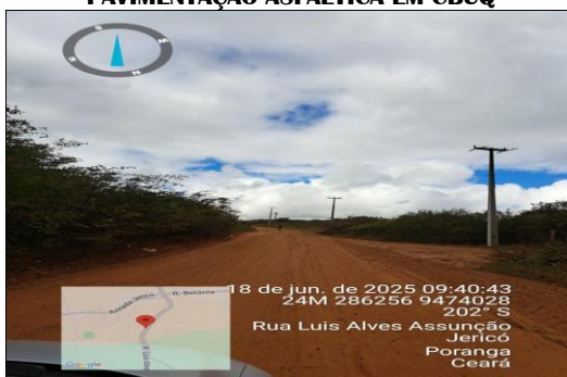
PAVIMENTAÇÃO ASFÁLTICA EM CBUQ
