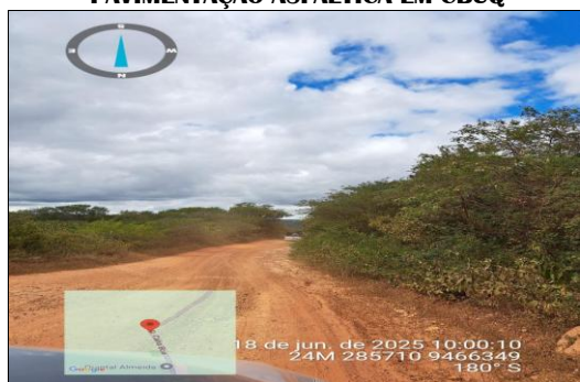
PAVIMENTAÇÃO ASFÁLTICA EM CBUQ
