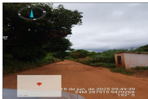
PAVIMENTAÇÃO ASFÁLTICA EM CBUQ
