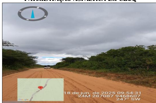
PAVIMENTAÇÃO ASFÁLTICA EM CBUQ
