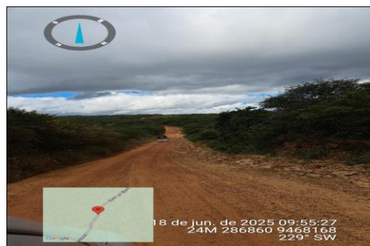
PAVIMENTAÇÃO ASFÁLTICA EM CBUQ
