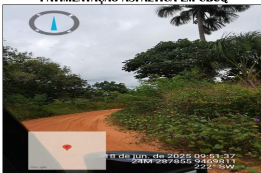
PAVIMENTAÇÃO ASFÁLTICA EM CBUQ
