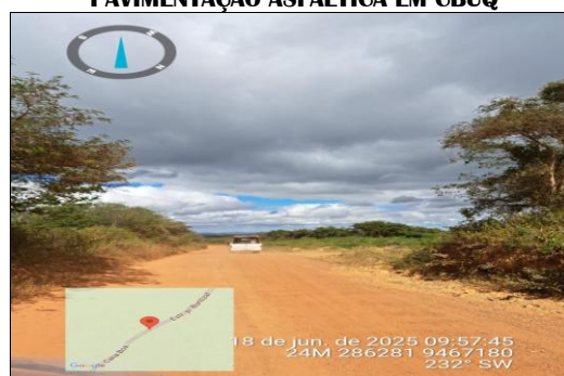
PAVIMENTAÇÃO ASFÁLTICA EM CBUQ
