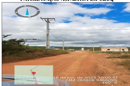
PAVIMENTAÇÃO ASFÁLTICA EM CBUQ
