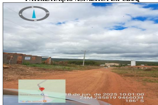
PAVIMENTAÇÃO ASFÁLTICA EM CBUQ
