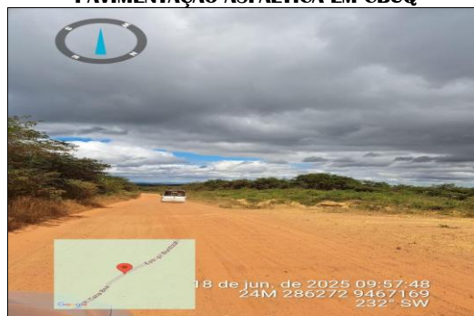
PAVIMENTAÇÃO ASFÁLTICA EM CBUQ
