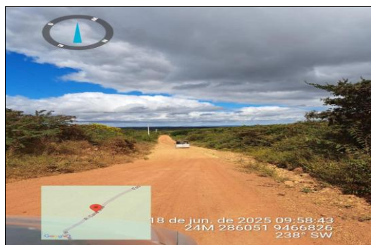
PAVIMENTAÇÃO ASFÁLTICA EM CBUQ
