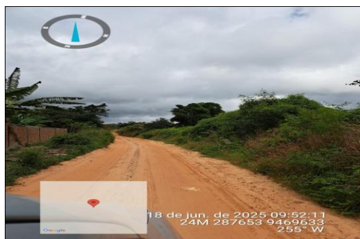
PAVIMENTAÇÃO ASFÁLTICA EM CBUQ
