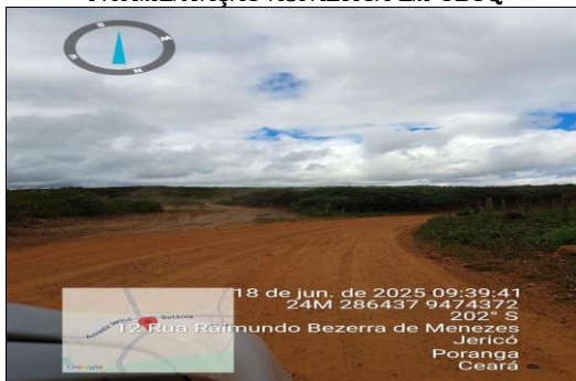
PAVIMENTAÇÃO ASFÁLTICA EM CBUQ
