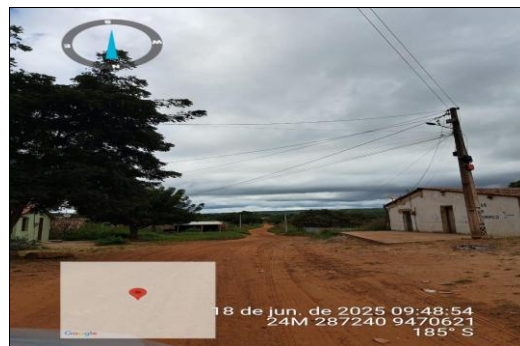
PAVIMENTAÇÃO ASFÁLTICA EM CBUQ
