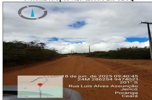
PAVIMENTAÇÃO ASFÁLTICA EM CBUQ
