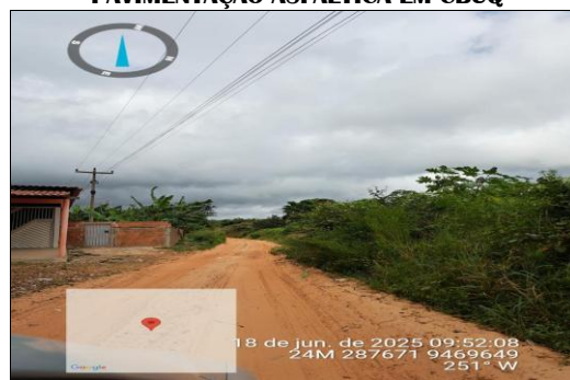
PAVIMENTAÇÃO ASFÁLTICA EM CBUQ
