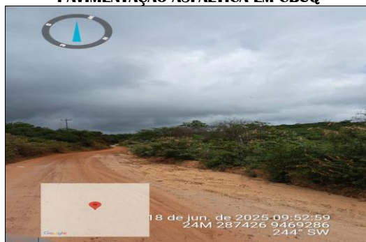
PAVIMENTAÇÃO ASFÁLTICA EM CBUQ
