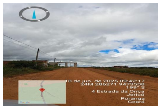
PAVIMENTAÇÃO ASFÁLTICA EM CBUQ
