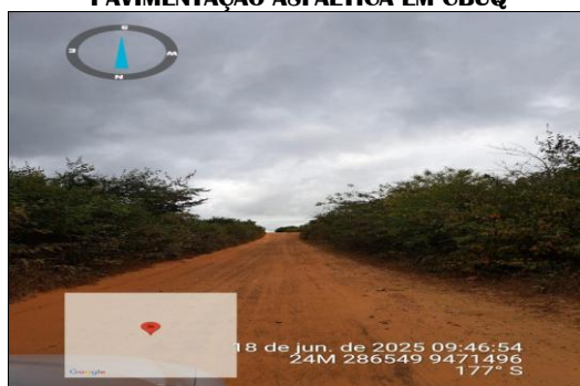
PAVIMENTAÇÃO ASFÁLTICA EM CBUQ
