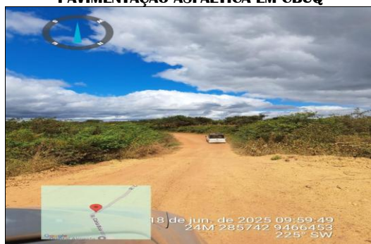
PAVIMENTAÇÃO ASFÁLTICA EM CBUQ
