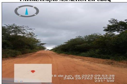
PAVIMENTAÇÃO ASFÁLTICA EM CBUQ
