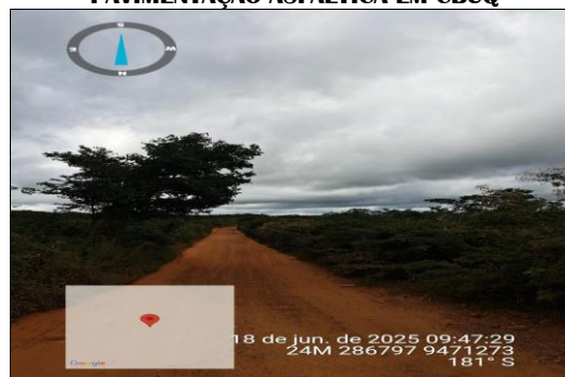
PAVIMENTAÇÃO ASFÁLTICA EM CBUQ
