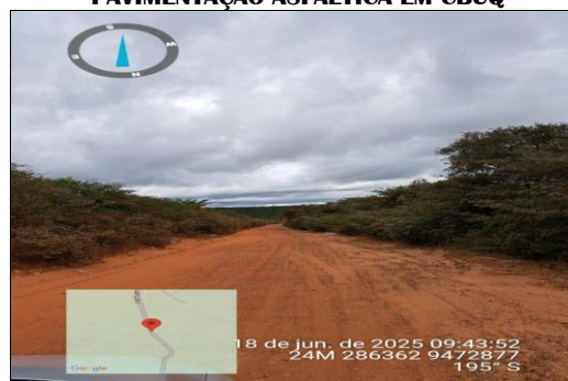
PAVIMENTAÇÃO ASFÁLTICA EM CBUQ
