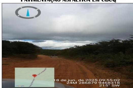
PAVIMENTAÇÃO ASFÁLTICA EM CBUQ
