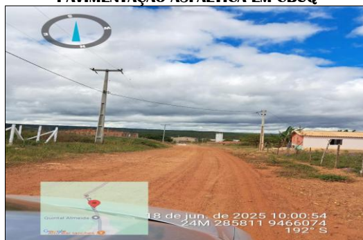
PAVIMENTAÇÃO ASFÁLTICA EM CBUQ
