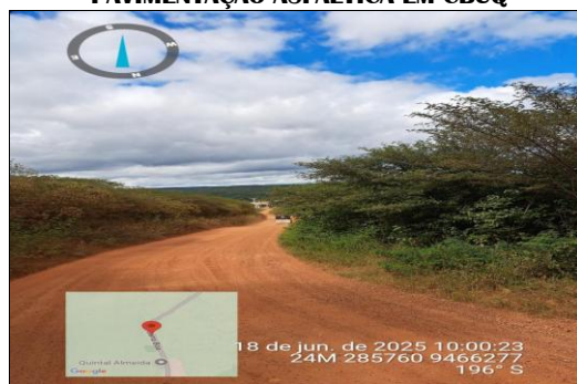
PAVIMENTAÇÃO ASFÁLTICA EM CBUQ
