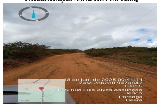
PAVIMENTAÇÃO ASFÁLTICA EM CBUQ
