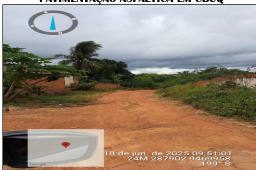
PAVIMENTAÇÃO ASFÁLTICA EM CBUQ
