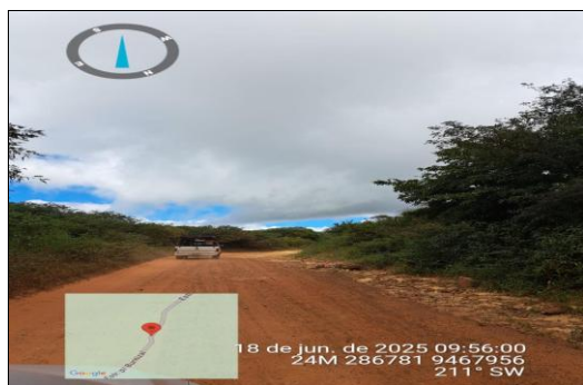
PAVIMENTAÇÃO ASFÁLTICA EM CBUQ
