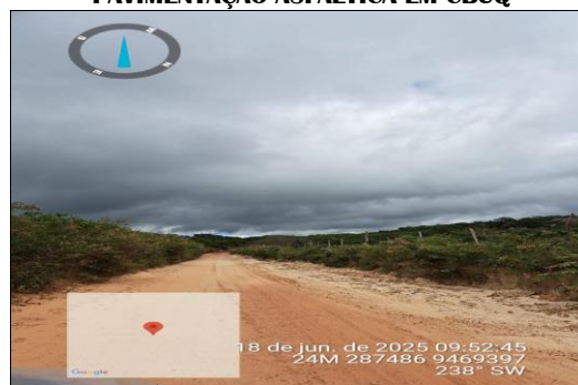
PAVIMENTAÇÃO ASFÁLTICA EM CBUQ
