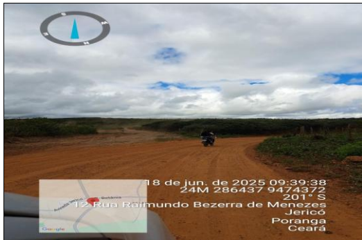
PAVIMENTAÇÃO ASFÁLTICA EM CBUQ
