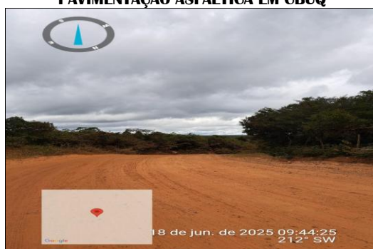
PAVIMENTAÇÃO ASFÁLTICA EM CBUQ
