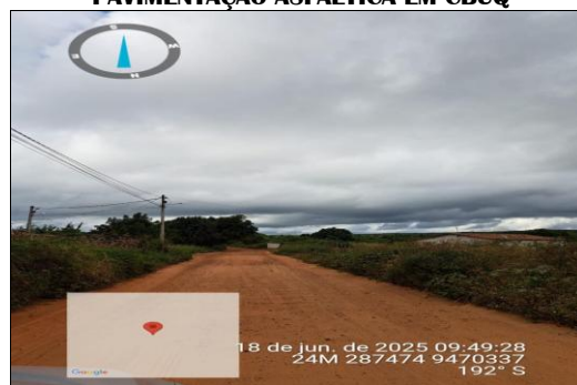
PAVIMENTAÇÃO ASFÁLTICA EM CBUQ
