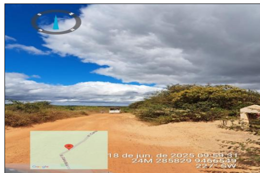
PAVIMENTAÇÃO ASFÁLTICA EM CBUQ
