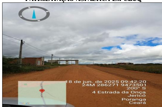
PAVIMENTAÇÃO ASFÁLTICA EM CBUQ
