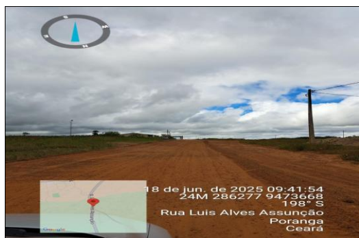
PAVIMENTAÇÃO ASFÁLTICA EM CBUQ
