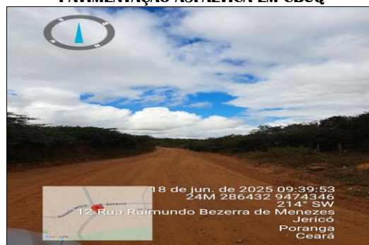
PAVIMENTAÇÃO ASFÁLTICA EM CBUQ
