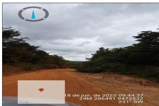
PAVIMENTAÇÃO ASFÁLTICA EM CBUQ
