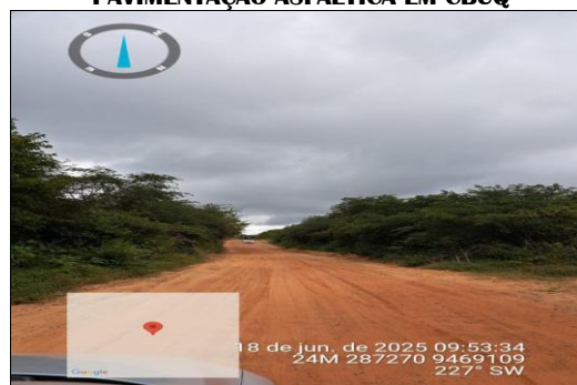
PAVIMENTAÇÃO ASFÁLTICA EM CBUQ
