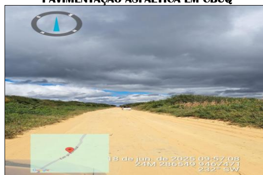
PAVIMENTAÇÃO ASFÁLTICA EM CBUQ
