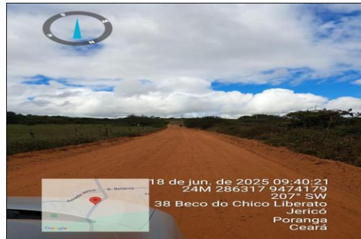
PAVIMENTAÇÃO ASFÁLTICA EM CBUQ
