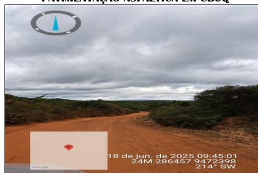
PAVIMENTAÇÃO ASFÁLTICA EM CBUQ
