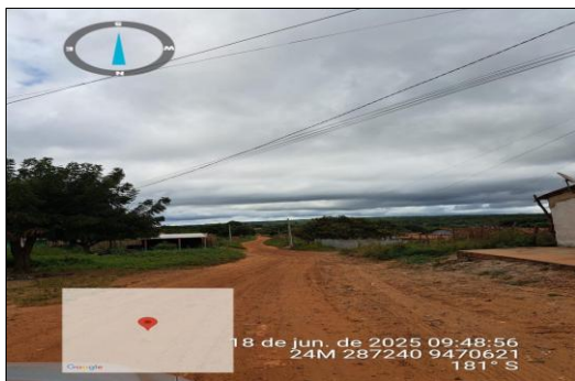
PAVIMENTAÇÃO ASFÁLTICA EM CBUQ
