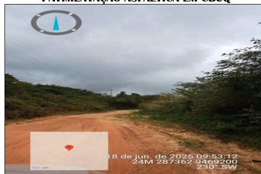
PAVIMENTAÇÃO ASFÁLTICA EM CBUQ
