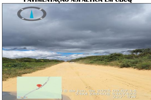
PAVIMENTAÇÃO ASFÁLTICA EM CBUQ
