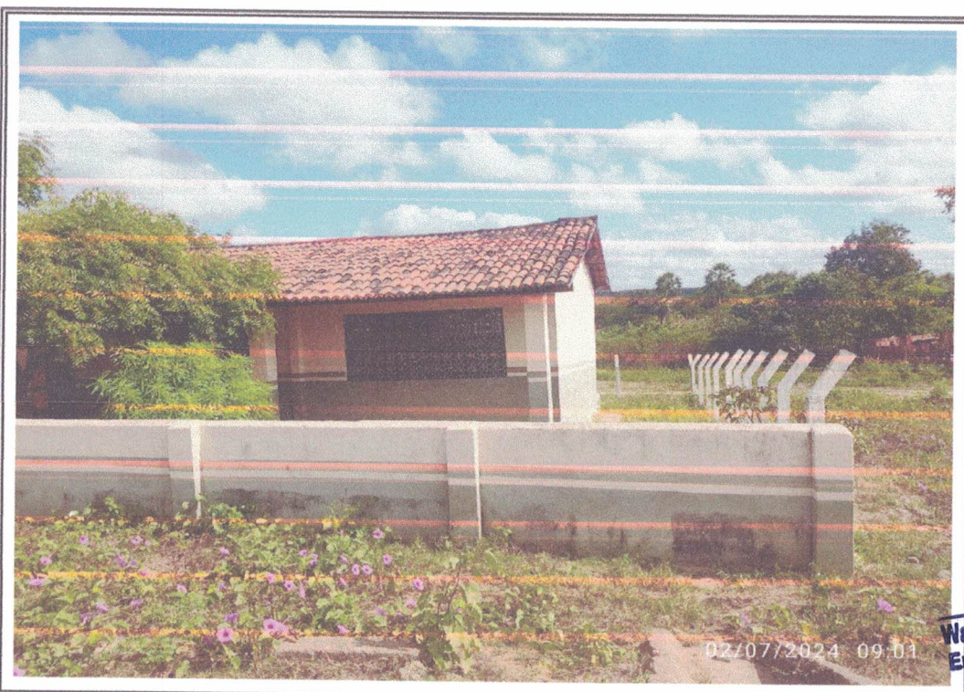
Foto 06- Vista da fachada escola
