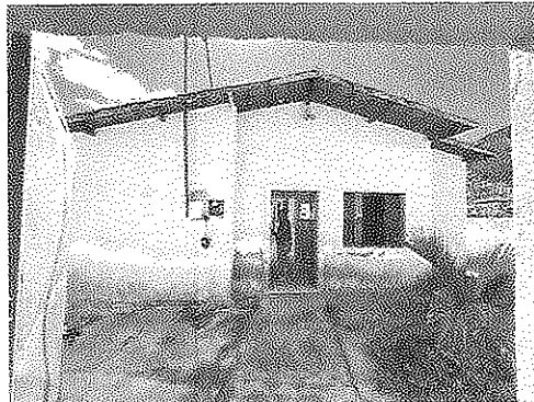
FOTO 02- FACHADA INTERNA PRINCIPAL
