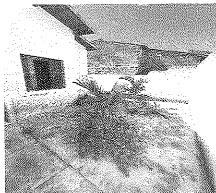
FOTO 04- FACHADA INTERNA PRINCIPAL
