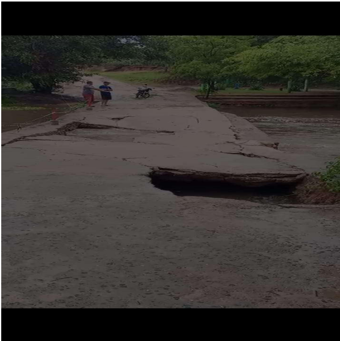
LOCAL DA OBRA – PASS.MOL. PANTANAL
