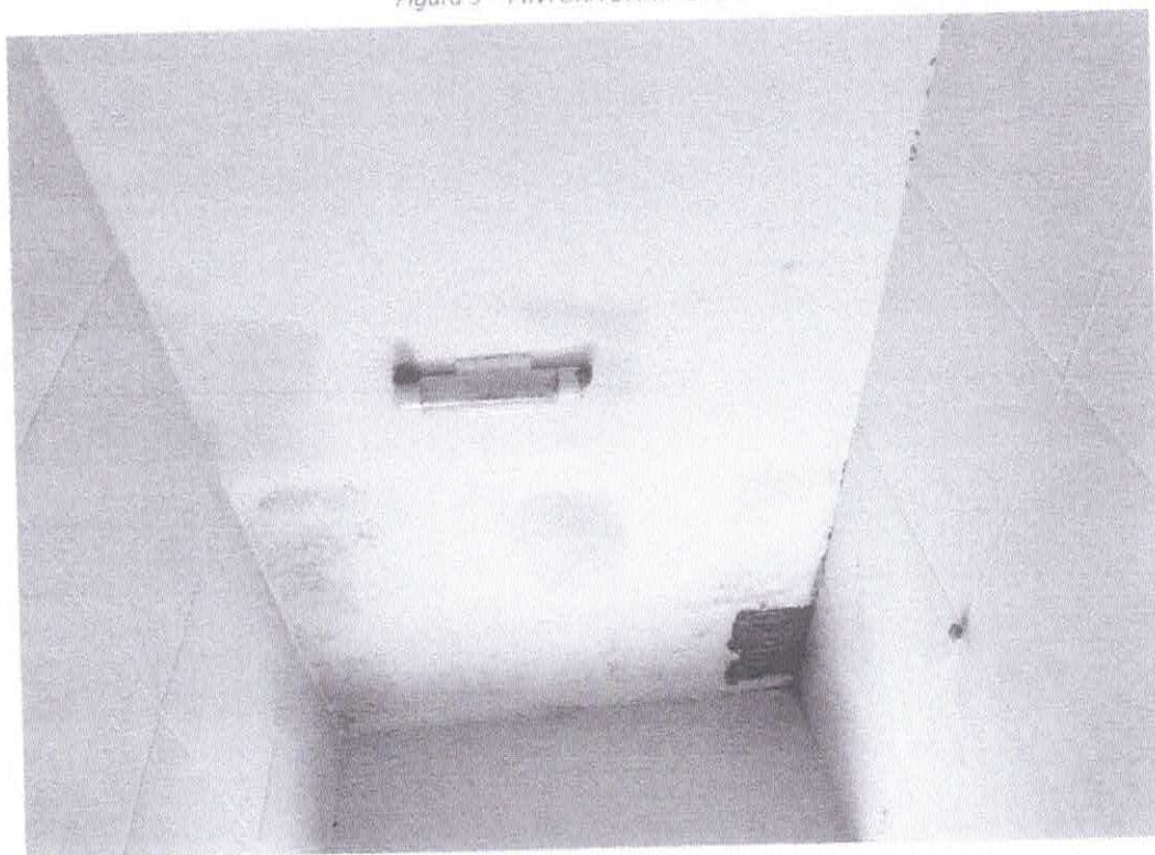
Figura 6 – PINTURA DANIFICADA
