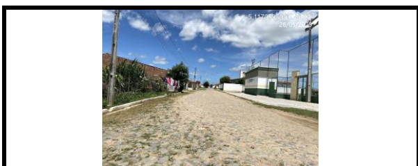
RUA JOSE VIEIRA DE FREITAS - RECREIO
