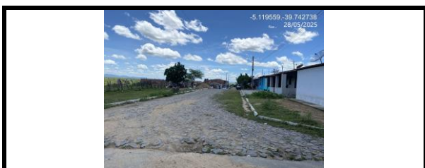
RUA CELCINA VIEIRA DE FREITAS - RECREIO
