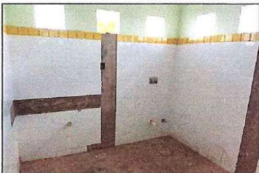
CERÂMICA E INSTALAÇÕES HIDRAULICAS
