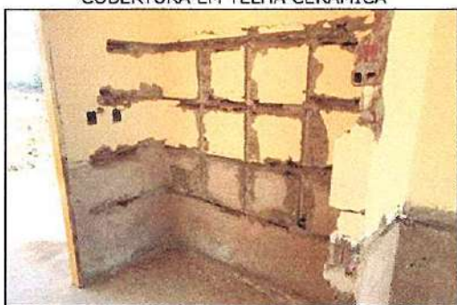
INSTALAÇÕES ELÉTRICAS
