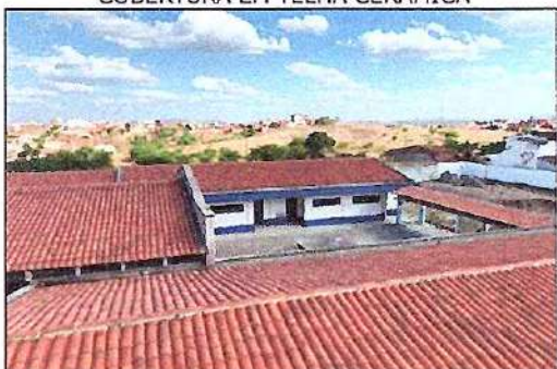
COBERTURA EM TELHA CERÂMICA
