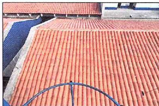
COBERTURA EM TELHA CERÂMICA
