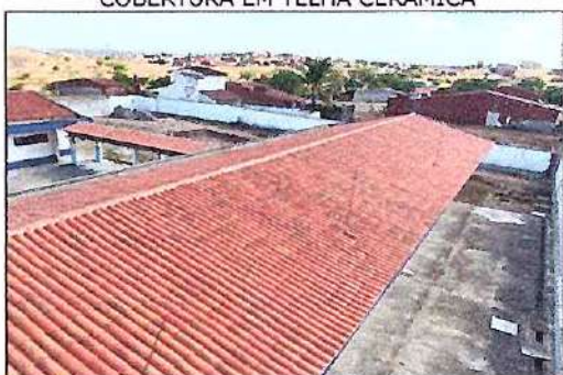
COBERTURA EM TELHA CERÂMICA
