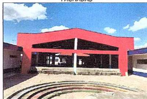
FACHADA PATIO COBERTO
