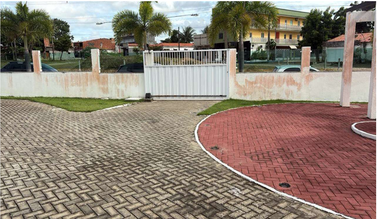
Vista do portão de acesso principal da Câmara Municipal de São Gonçalo do Amarante-CE
