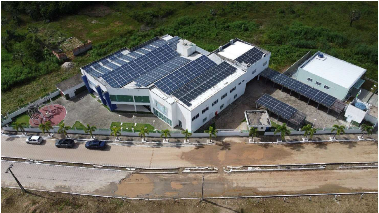
Vista aérea frontal e lateral da Câmara Municipal de São Gonçalo do Amarante-CE
