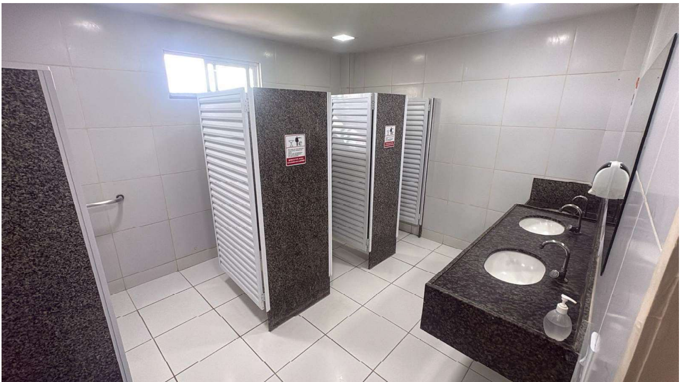
Vista do banheiro social feminino no pavimento superior do prédio da Câmara Municipal de São Gonçalo do Amarante-CE
