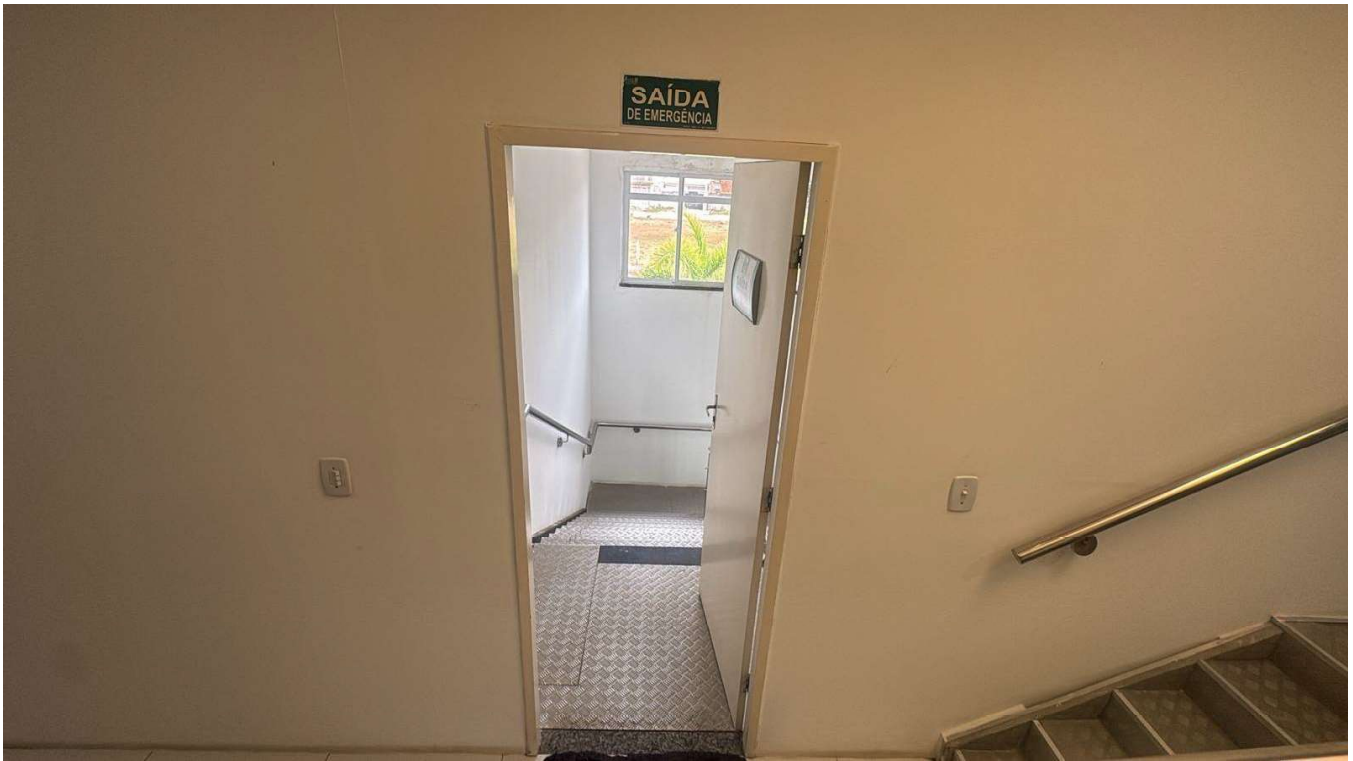
Vista da saída de emergência no pavimento superior do prédio da Câmara Municipal de São Gonçalo do Amarante-CE
