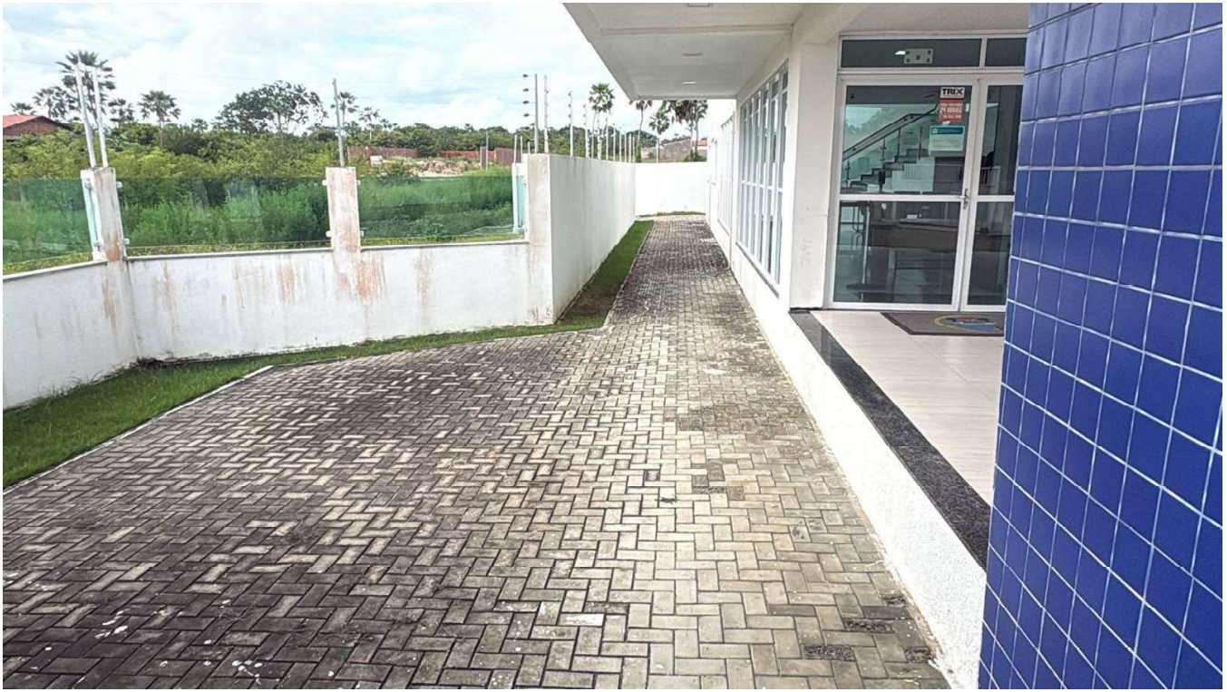
Vista do passeio interno do prédio da Câmara Municipal de São Gonçalo do Amarante-CE
