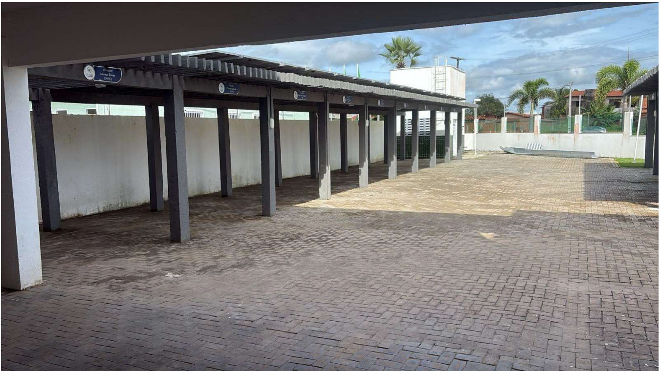
Vista do estacionamento do prédio da Câmara Municipal de São Gonçalo do Amarante-CE
