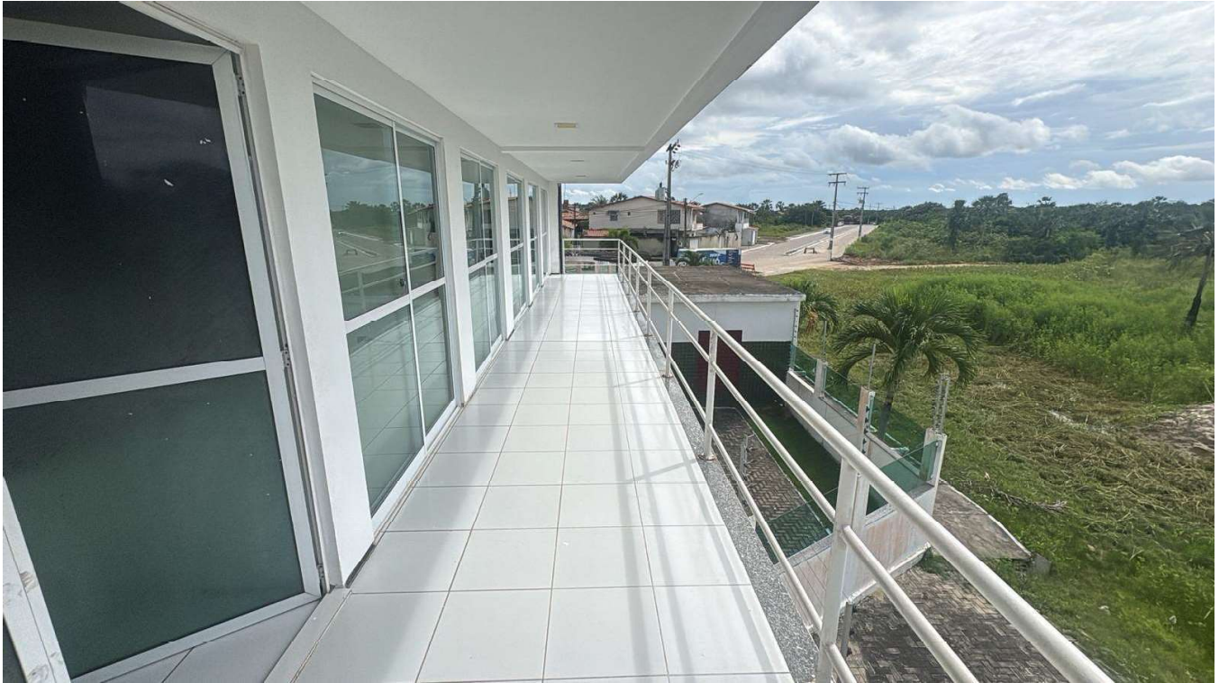
Vista externa da sacada no pavimento superior do prédio da Câmara Municipal de São Gonçalo do Amarante-CE
