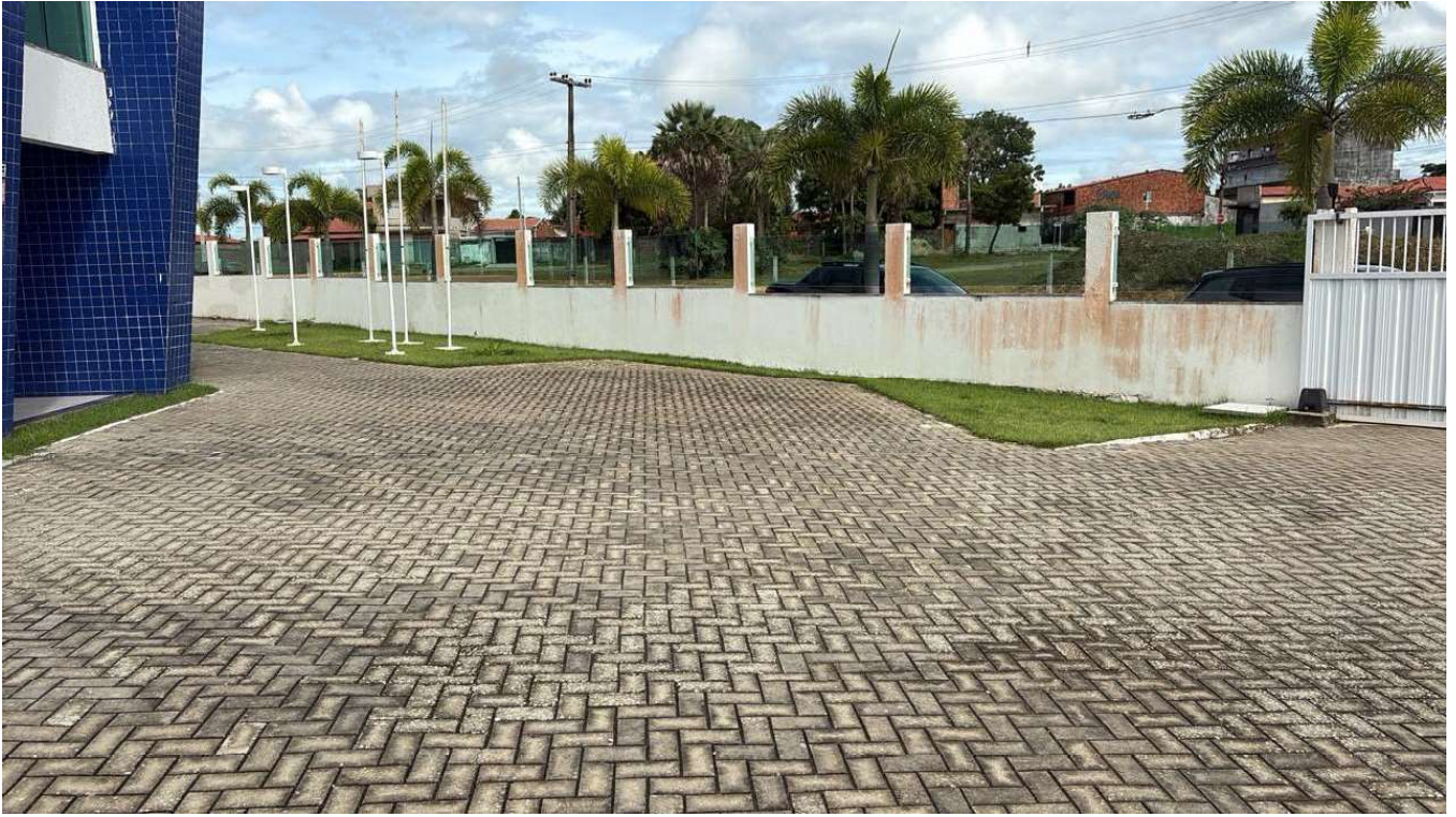
Vista da entrada externa da Câmara Municipal de São Gonçalo do Amarante-CE
