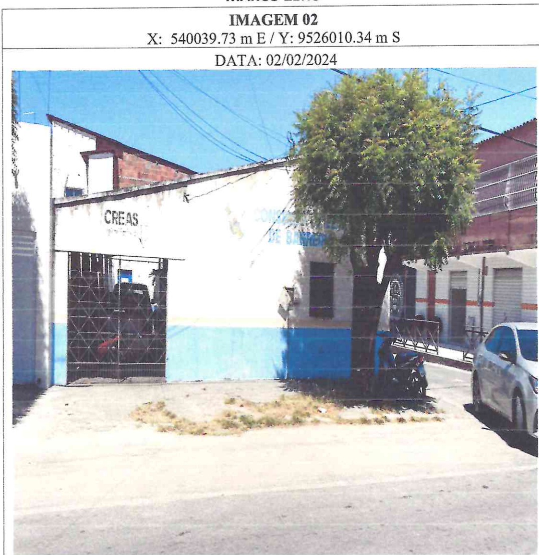
Figura 2: imagens do local da obra
