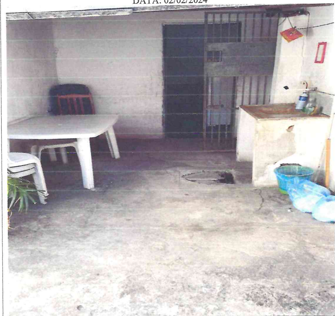
Figura 5: imagens do local da obra]
