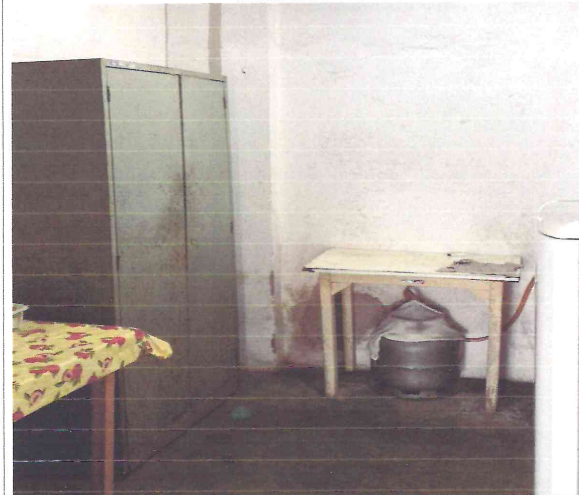
Figura 3: imagens do local da obra
