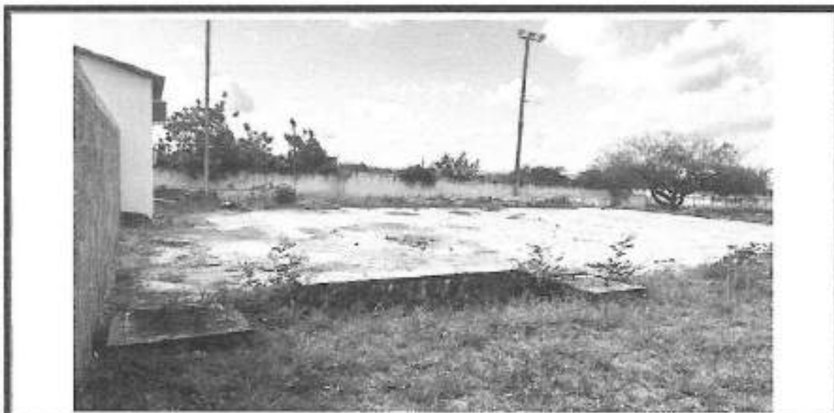
Figura 17 – AMPLIAÇÃO DA ESCOLA
