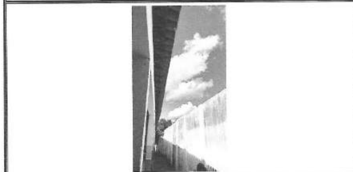
Figura 08 – AMPLIAÇÃO DA COBERTA
