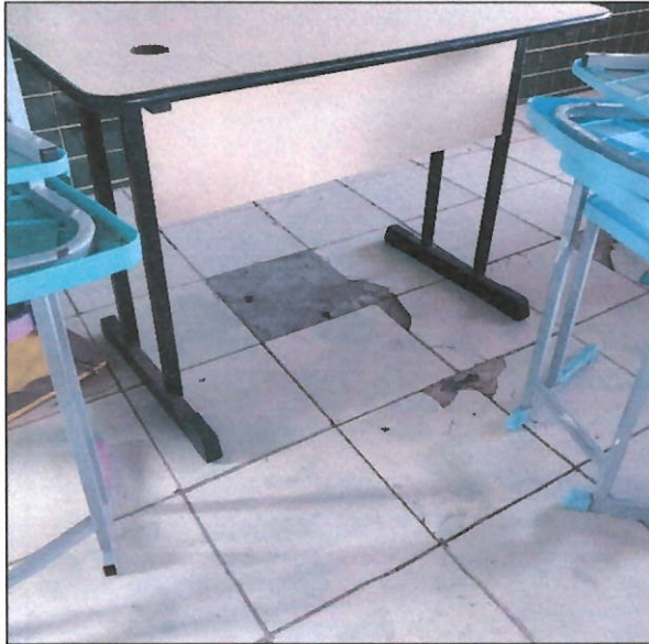
Figura 3: Piso de salas de aula degradados.
