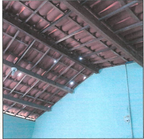
Figura 4: Coberta com pontos críticos.
