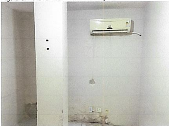
Figura 4: Parede interna com deslocamento de textura.
