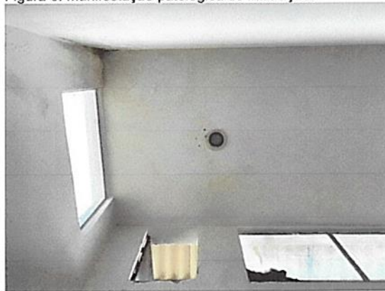
Figura 6: Manifestação patológica de infiltração.
