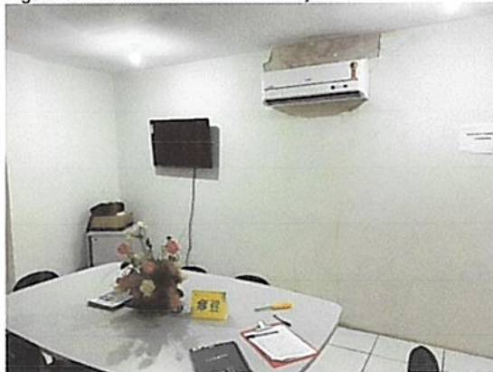
Figura 6: Manifestação patológica de infiltração.
