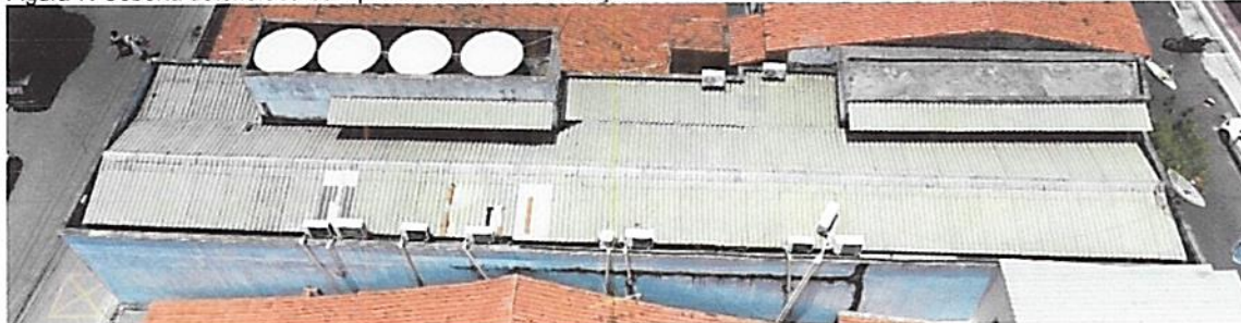
Figura 7: Coberta deteriorada com pontos críticos de infiltração.
