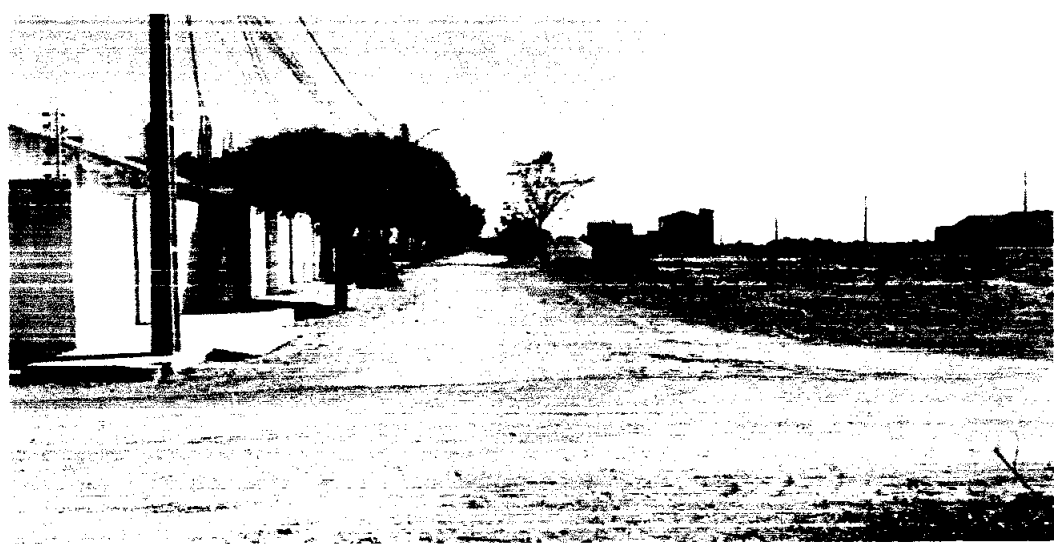
INÍCIO DA TRAVESSA RAIMUNDO NONATO DE SOUSA A SER PAVIMENTADO E(X) 612.484,97 m,N(Y) 9.439.512,10 m,E
