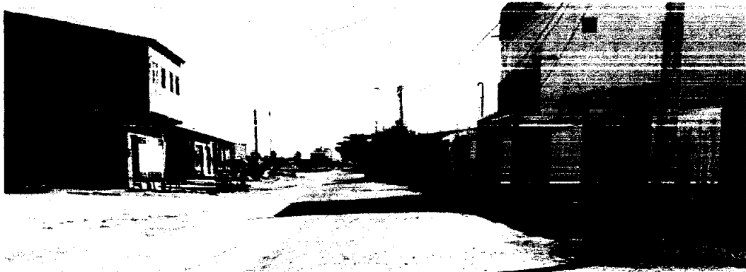
INÍCIO DA RUA HADOQUE COSTA A SER PAVIMENTADO E(X) 612.434,11 m,N(Y) 9.439.535,61 m,E
