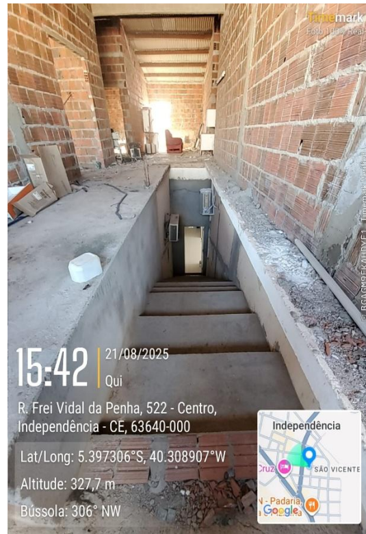
Foto 14 e 15: Escada de acesso ao pavimento superior em desconformidade as NBR 9050 e NBR 9077.
