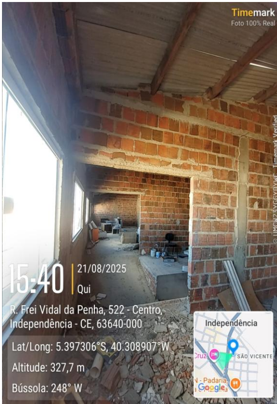
Foto 24 e 25: Paredes de alvenária, piso necessidade regularização, viga invertida aparente
