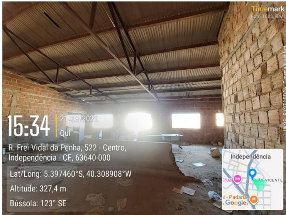
Foto 32: Paredes de alvenária, piso necessidade regularização
