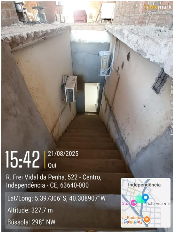
Foto 14 e 15: Escada de acesso ao pavimento superior em desconformidade as NBR 9050 e NBR 9077.
