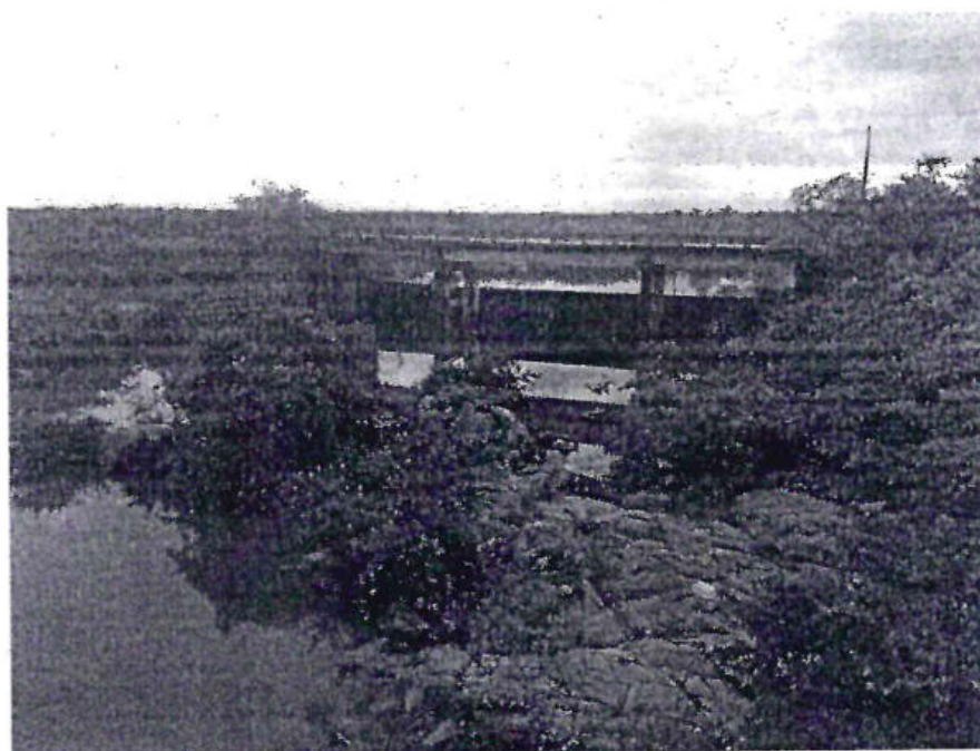
Foto 02- Barragem na Localidade de Cristais
