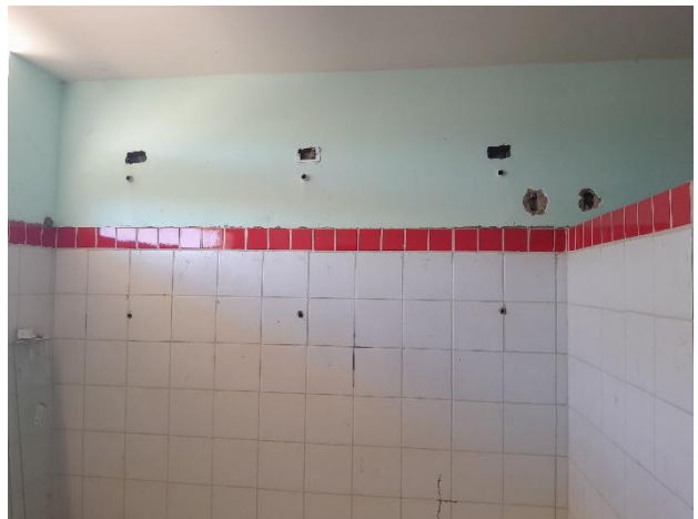
Área de chuveiro do Sanitário I do Bloco de Multiuso
