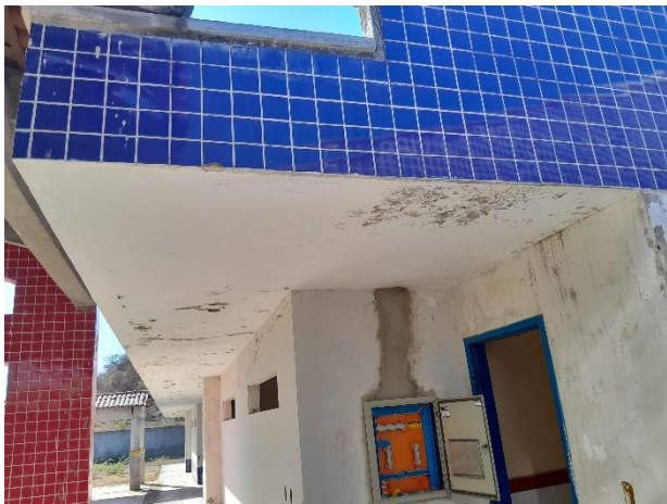
Quadro Elétrico da Creche I
