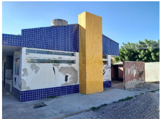
Fachada externa do Bloco de Serviço
