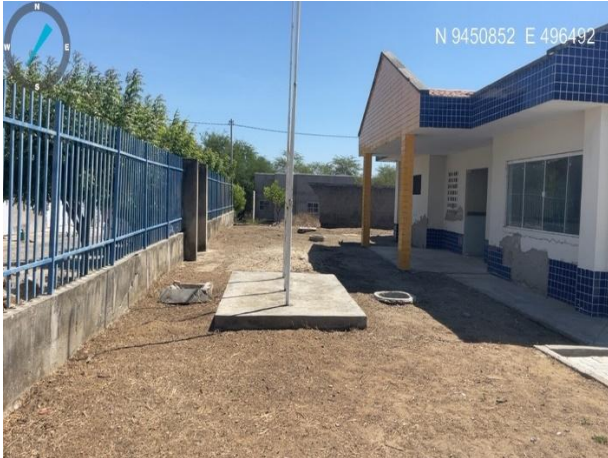
Fachada da edificação
