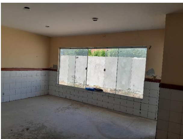
Área da sala da Creche II
