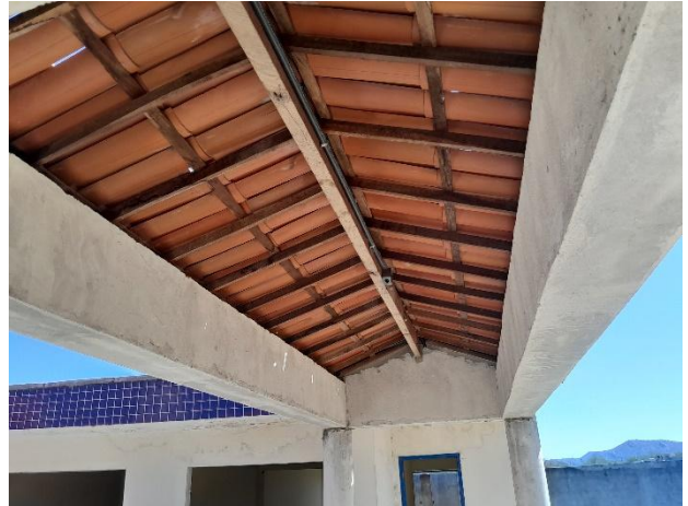
Coberta da Passarela
