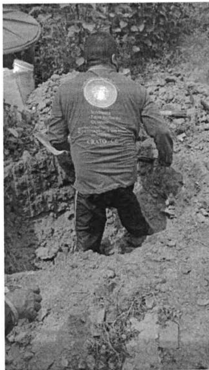
FOTO 2 – FASE DE REGULARIZAÇÃO DA VALA MAIOR
