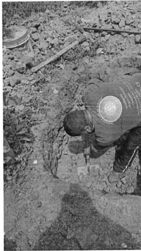
FOTO 1 – FASE DE ESCAVAÇÃO DA VALA MENOR
