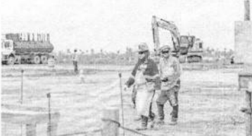
CONSTRUÇÃO DO data center do TikToK na ZPE do Ceará
