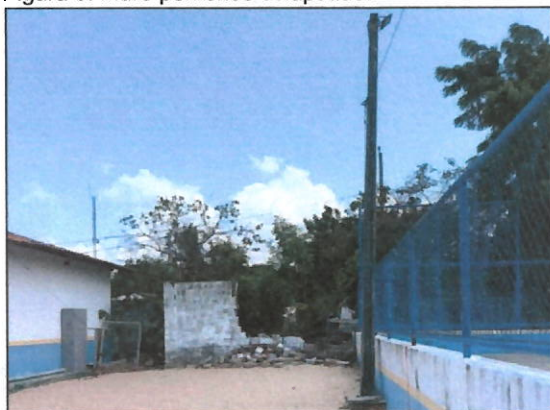
Figura 8: Muro periférico colapsado.
