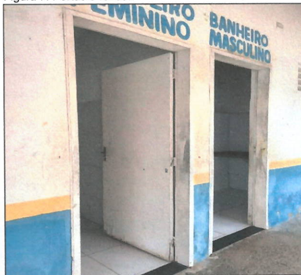
Figura 7: Portas e revestimento dos banheiros.
