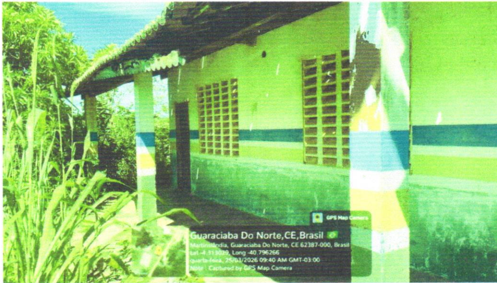
FOTO 04: Situação atual da edificação presente no terreno de construção da areninha
