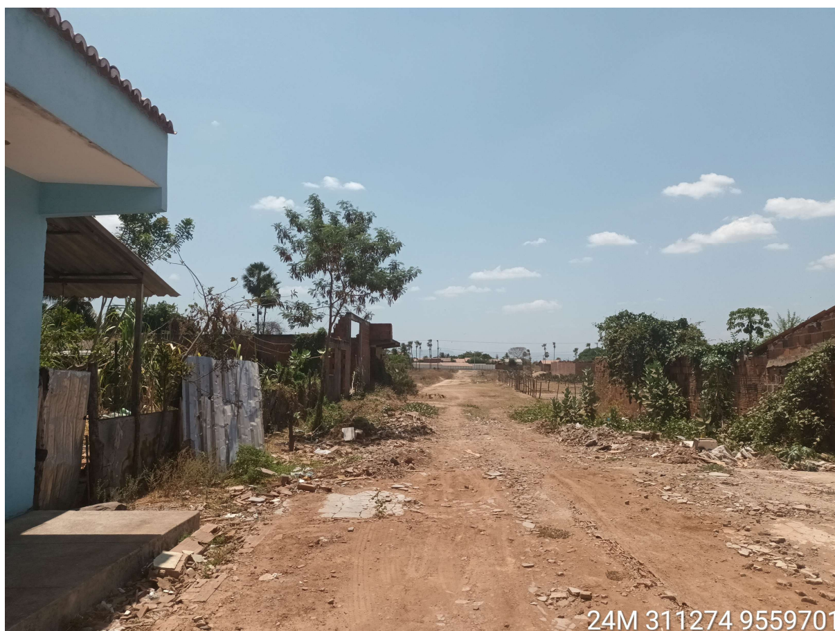
FOTO DO LOCAL DA OBRA
