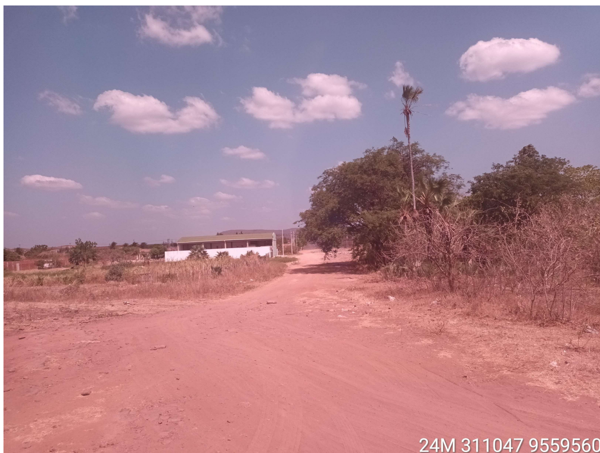
FOTO DO LOCAL DA OBRA
