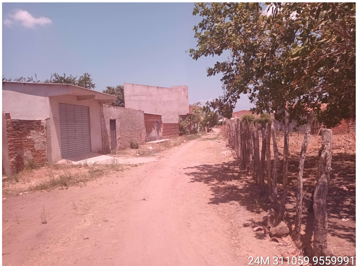
FOTO DO LOCAL DA OBRA
