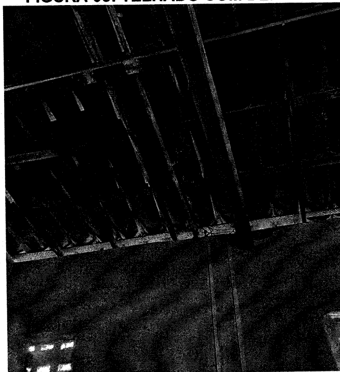
FIGURA 09: TELHADO COM DEFEITO
