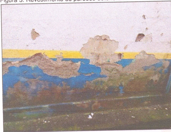
Figura 5: Ausência de revestimento.
