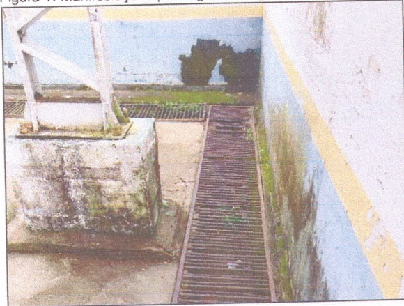
Figura 3: Revestimento de paredes deteriorado.
