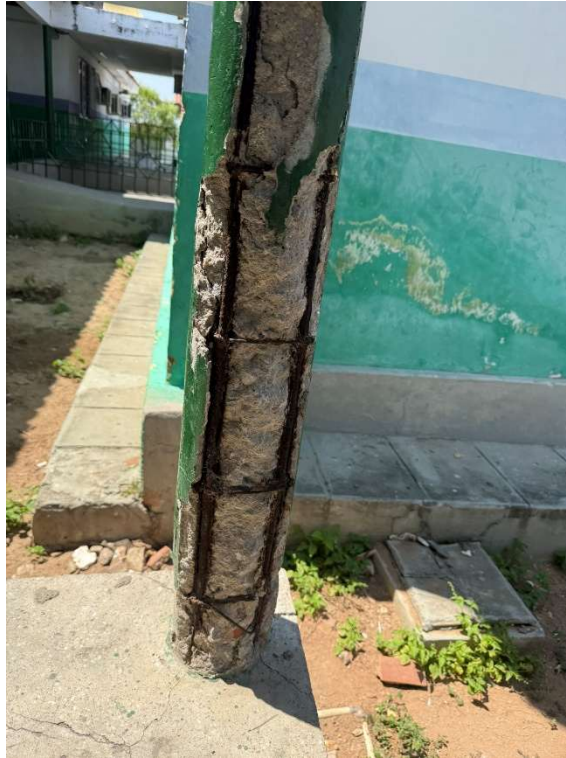
Figura 1 – PILAR DANIFICADO
