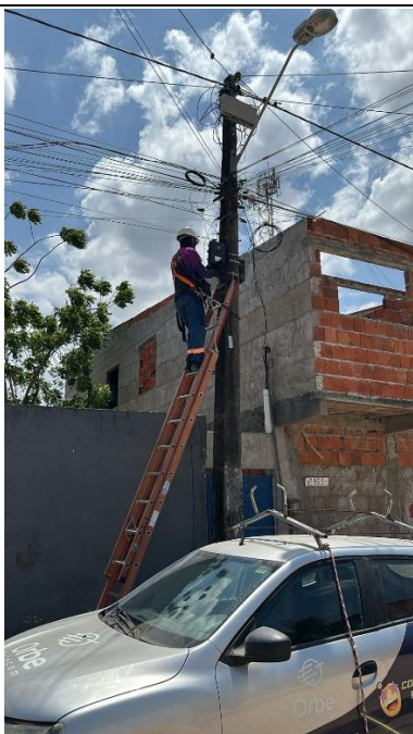
Instalação partindo da CTO
