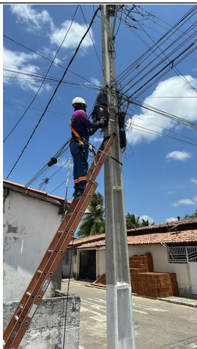
Instalação partindo da CTO
