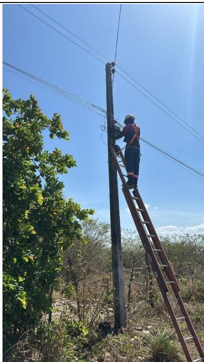
Instalação partindo da CTO
