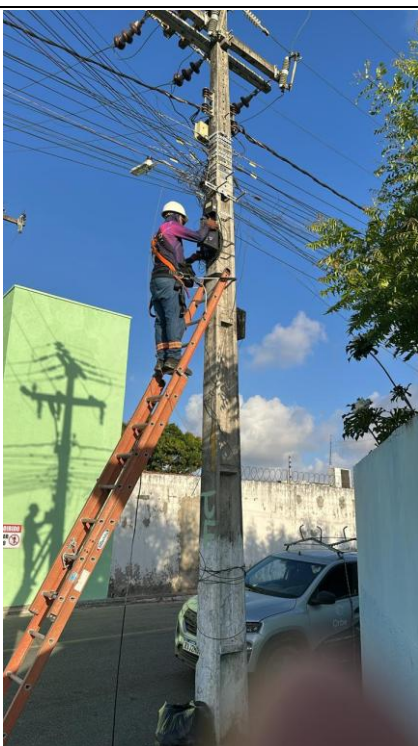
Instalação partindo da CTO
