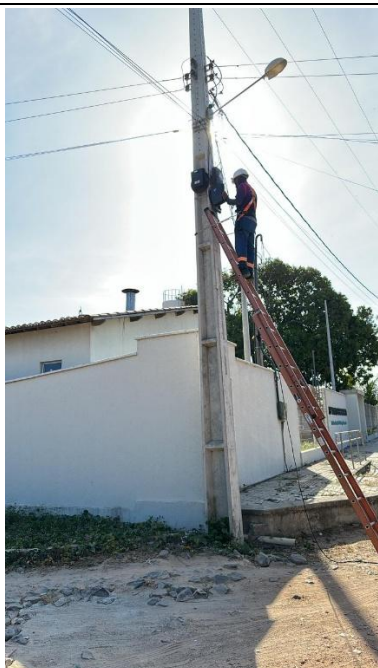
Instalação partindo da CTO
