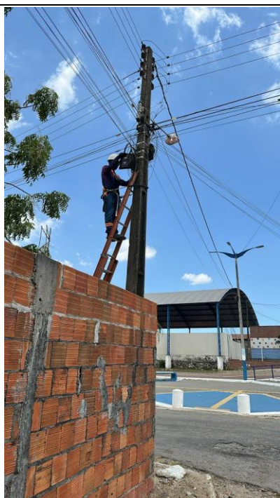
Instalação partindo da CTO
