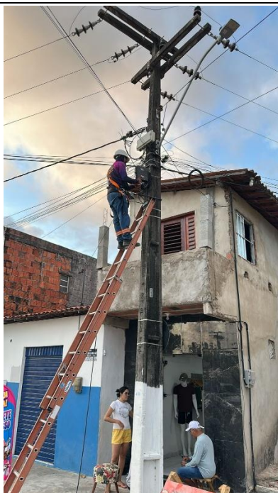
Instalação partindo da CTO
