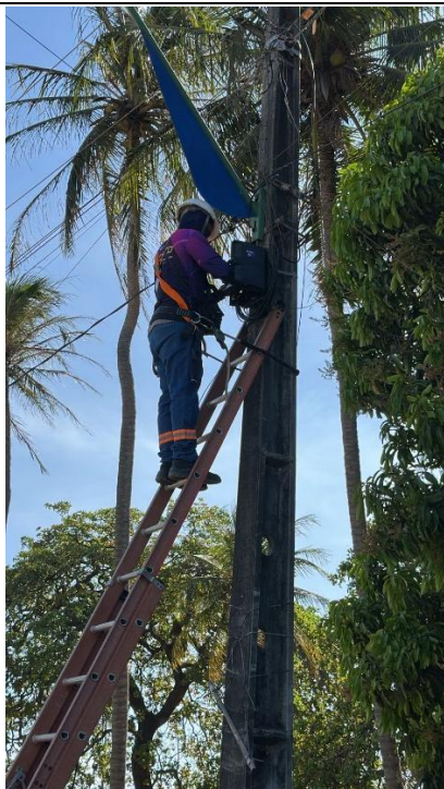
Instalação partindo da CTO
