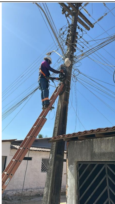
Instalação partindo da CTO
