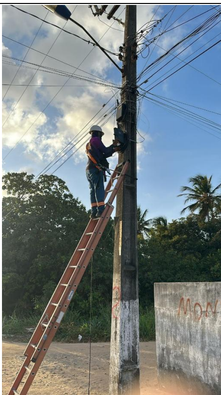
Instalação partindo da CTO
