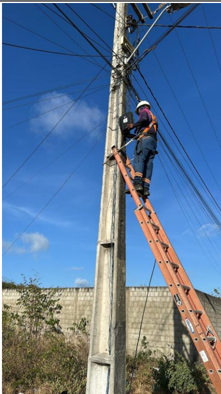
Instalação partindo da CTO
