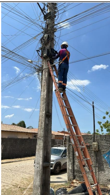
Instalação partindo da CTO
