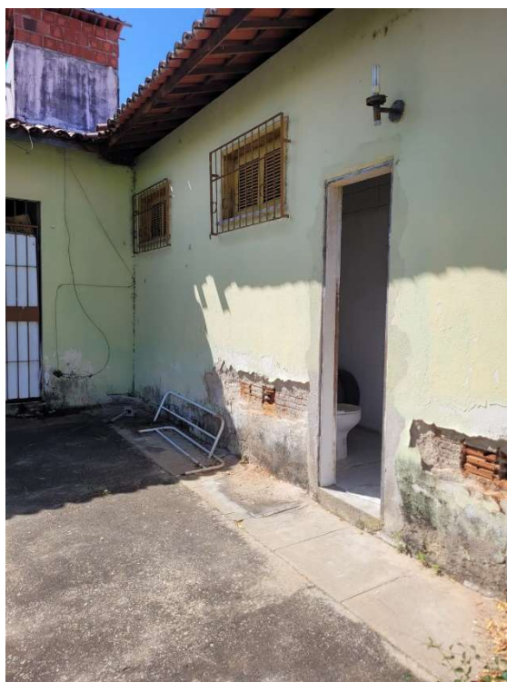
Figura 7 – REVESTIMENTOS DANIFICADOS
