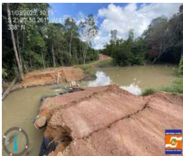
Ponte do Ramal da 81
