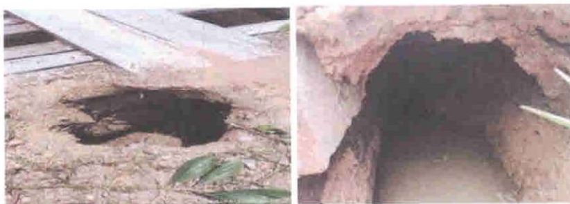
Ponte próximo a vila do café
