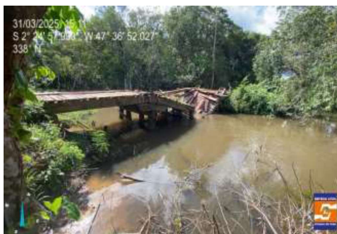
Ponte do Rio Cadirú - Mirim
