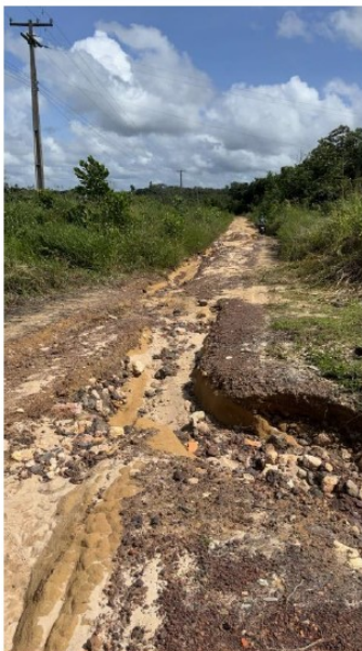
RAMAL DE ACESSO A COMUNIDADE SÃO JOSÉ DO MASSARANDUBA SENTIDO RAMAL DO KM 81 E SÃO PEDRO DA ÁGUA BRANCA
