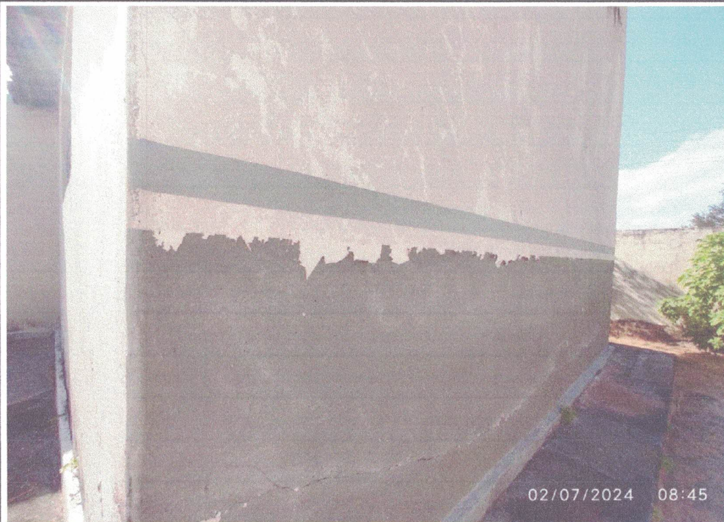
Foto 08- Paredes infiltracao
