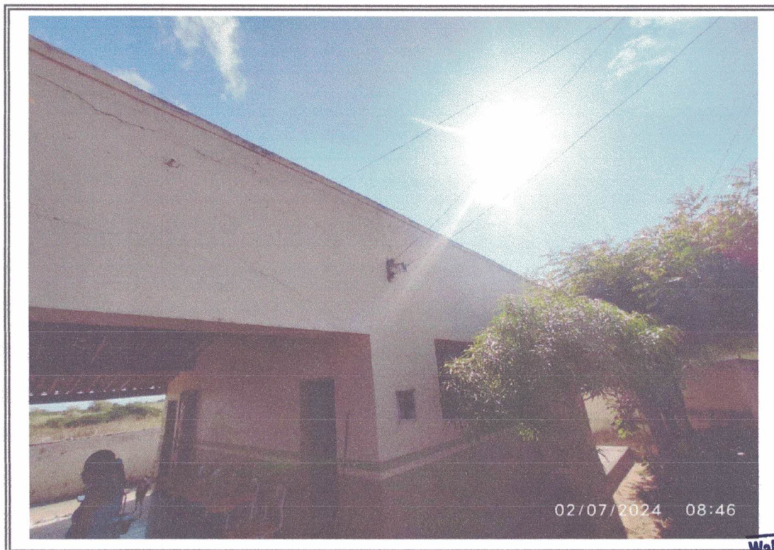
Foto 06- Vista da fachada escola
