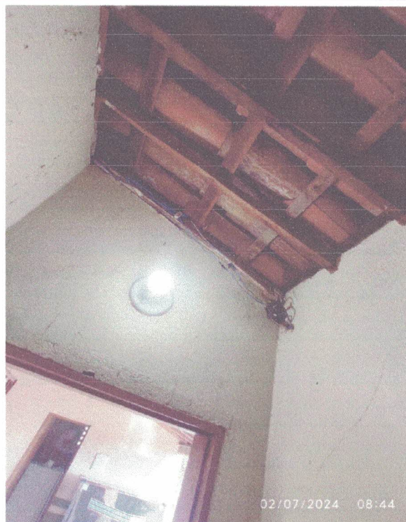
Foto 09 - Vista do telhado da escola
