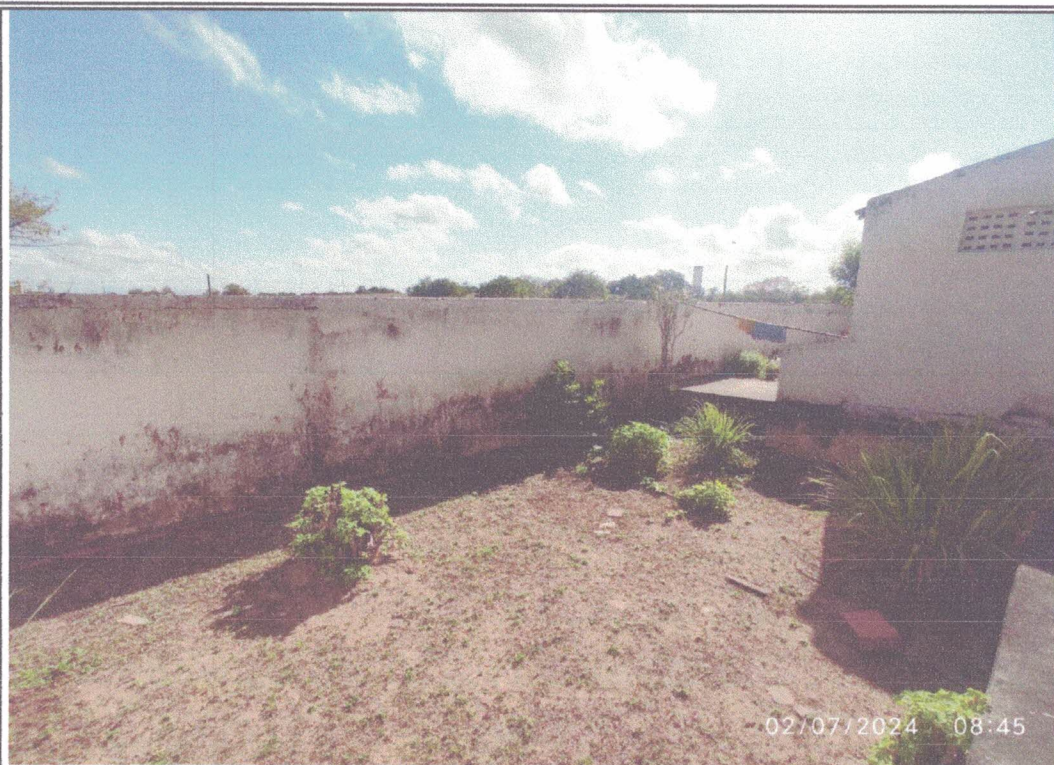
Foto 11 - Vista do muro
