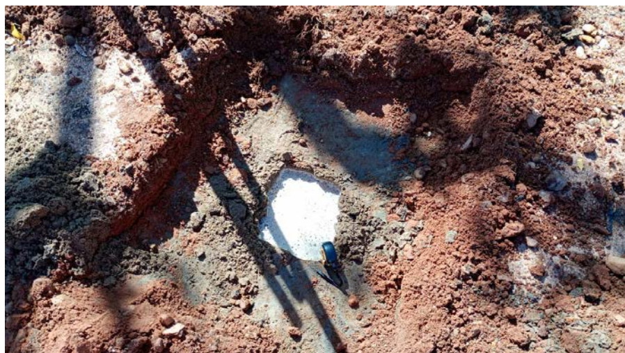
Figura 10 – Ensaio de infiltração 03.
