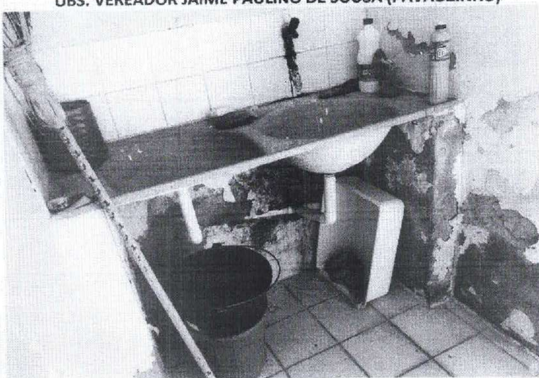
Figura 7 – REVESTIMENTO DANIFICADO
