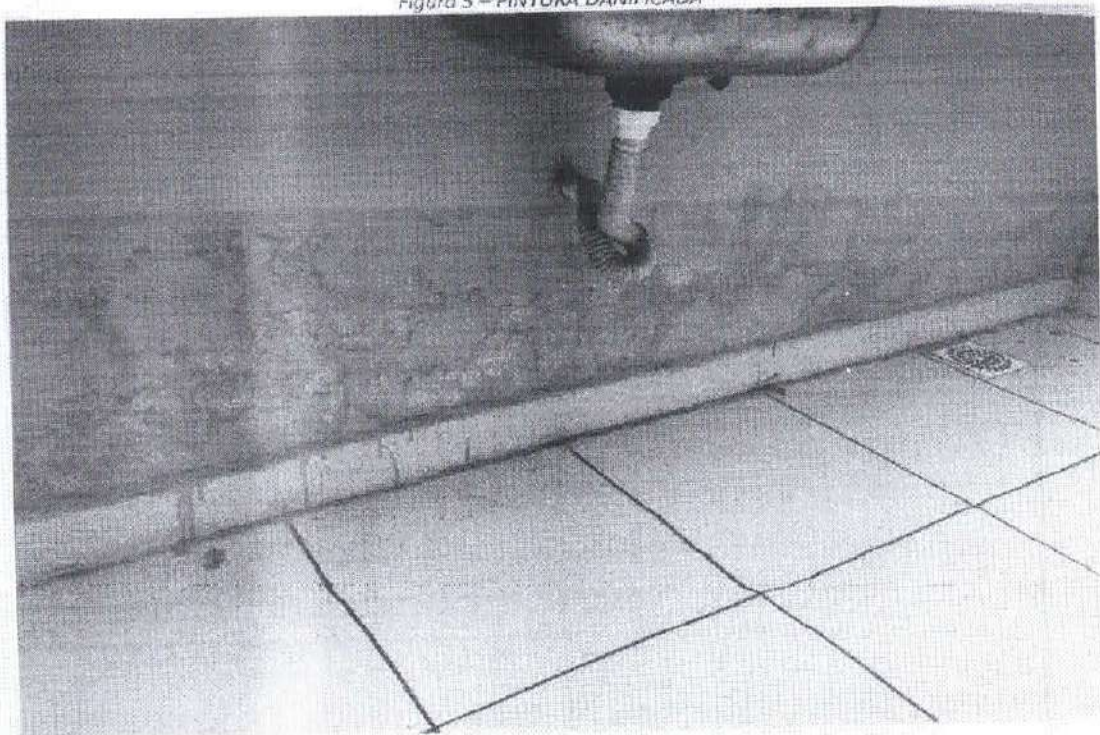
Figura 6 – REVESTIMENTO DANIFICADO
