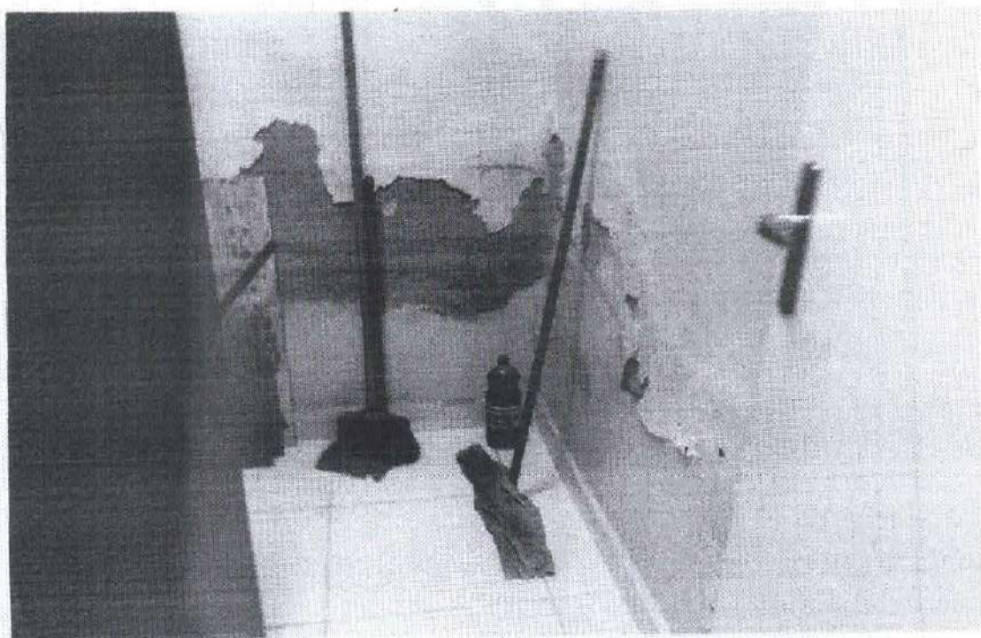
Figura 8 – REVESTIMENTO DANIFICADO
