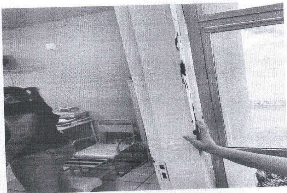
Figura 6 – FORRAMENTO DANIFICADO
