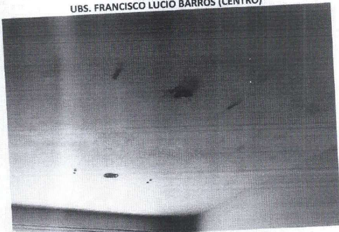
Figura 9 – FALTA DE LUMINÁRIAS
