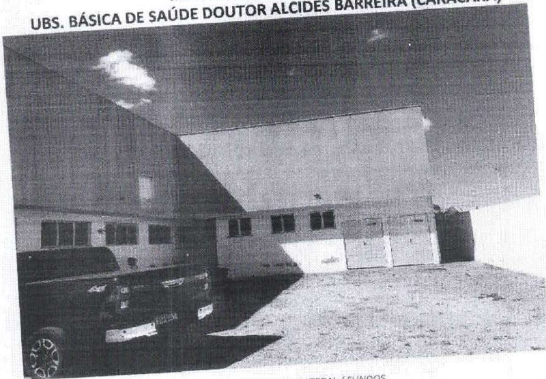
Figura 3 – FACHADA – LATERAL / FUNDOS
