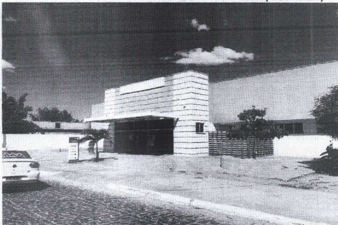
Figura 1 – FACHADA FRONTAL E CALÇADA
