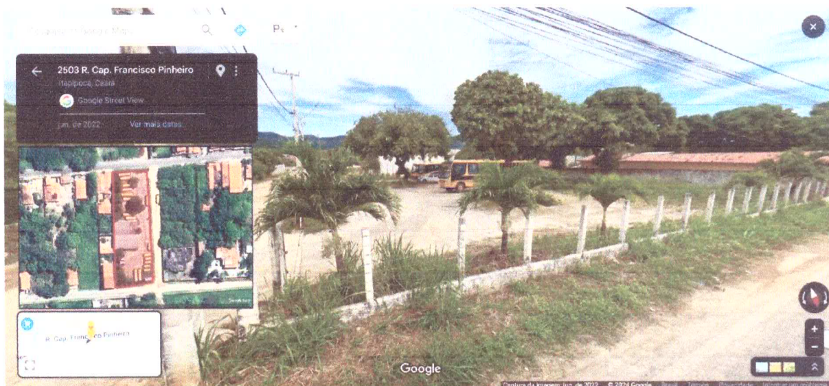
Figura 2: Garagem de veículos do município - Fachada norte.
