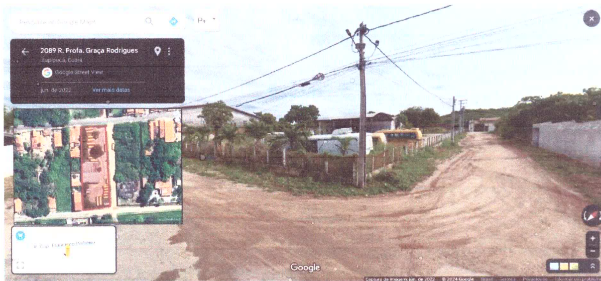
Figura 1: Garagem de veículos do município - Fachada sul.
