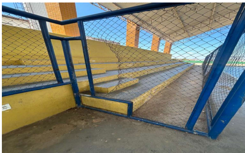
FOTO 02 – TELA DO ALAMBRADO DANIFICADA
