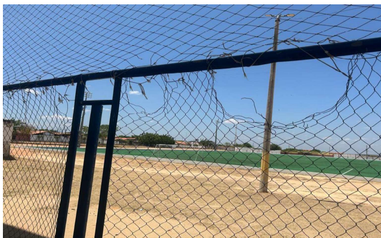
FOTO 04 – TELA DO ALAMBRADO DANIFICADA
