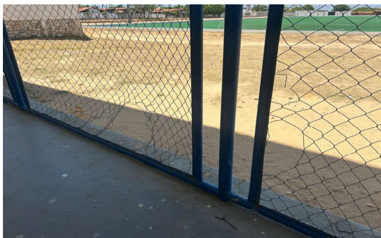
FOTO 03 – TELA DO ALAMBRADO DANIFICADA
