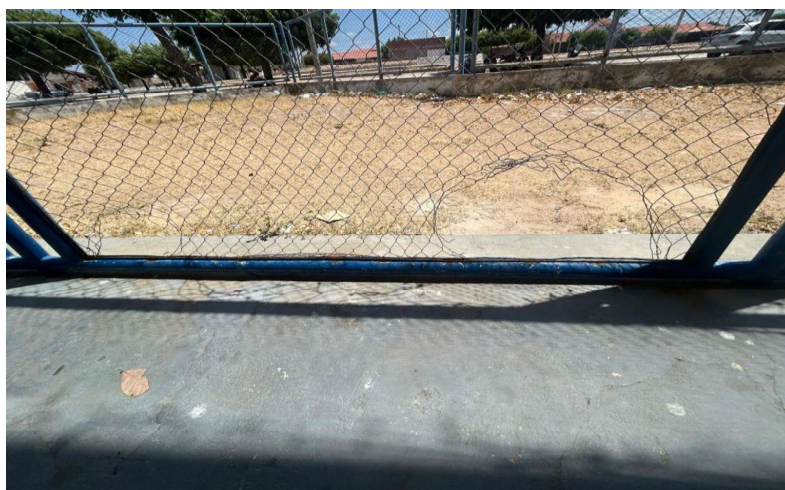
FOTO 01 – TELA DO ALAMBRADO DANIFICADA
